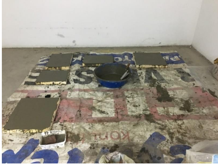
Şekil 6.10 Beton blok duvar imalatı.
