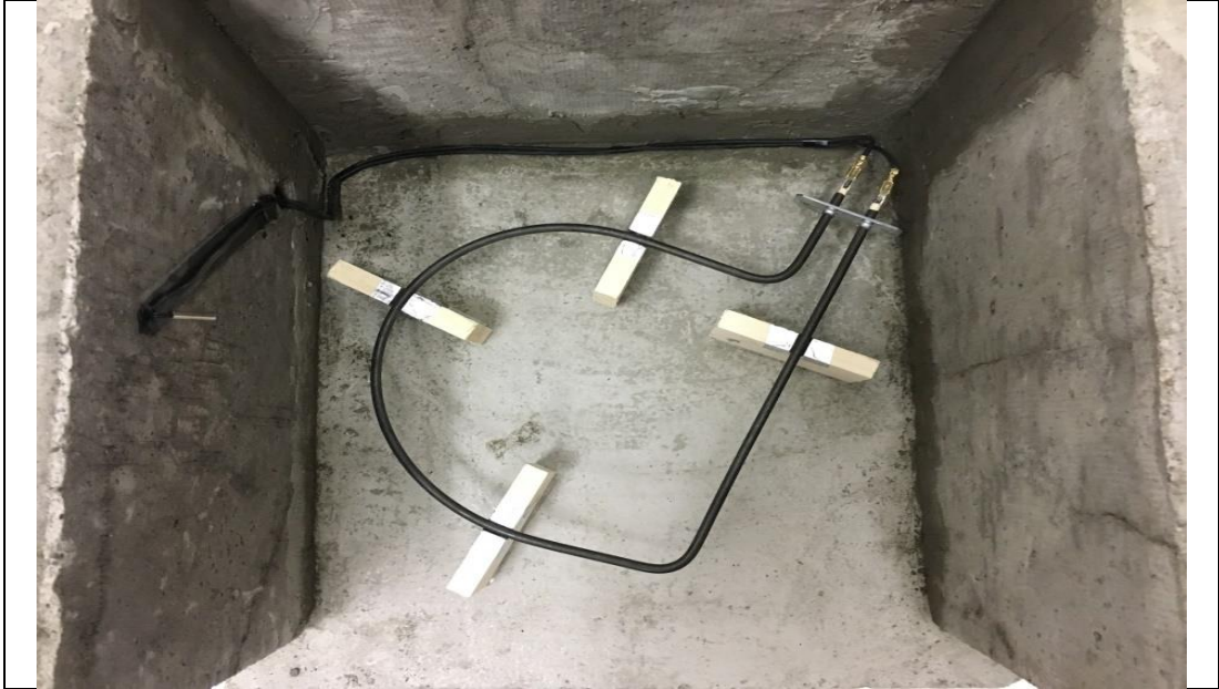
Şekil 6.2. Uygulama rezistans montajı.
