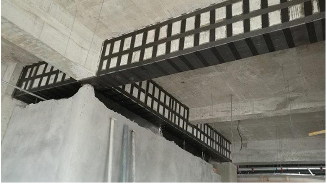
Şekil 2.12. Bir yapı uygulamasında güçlendirme amaçlı kullanılmış polimer matrisli kompozit malzemeler [5].
