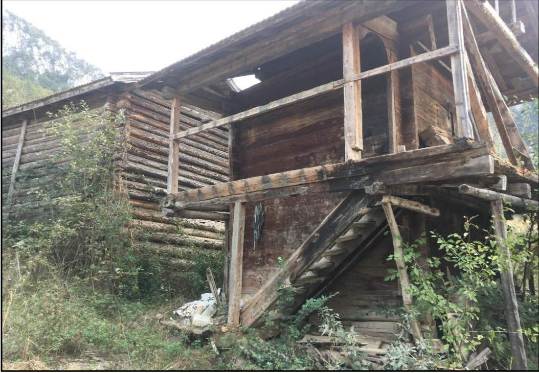
Fotoğraf 47. Ambarların alt kısmında yere çakılan dikmeler ve üst kata çıkmak için kullanılan merdiven, Nalbantođlu Mahallesi.
