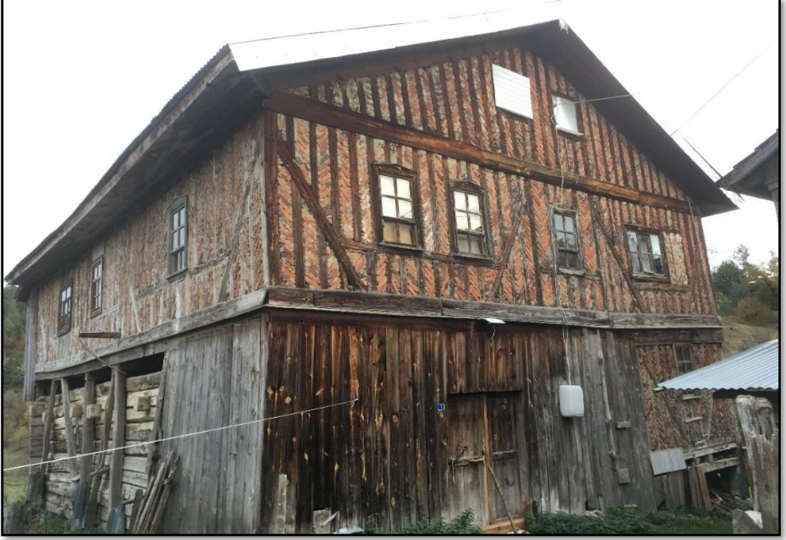
Fotoğraf 25. Ahşap çatma tekniği ile inşa edilmiş geleneksel mesken örneği, Sabuncular Köyü
