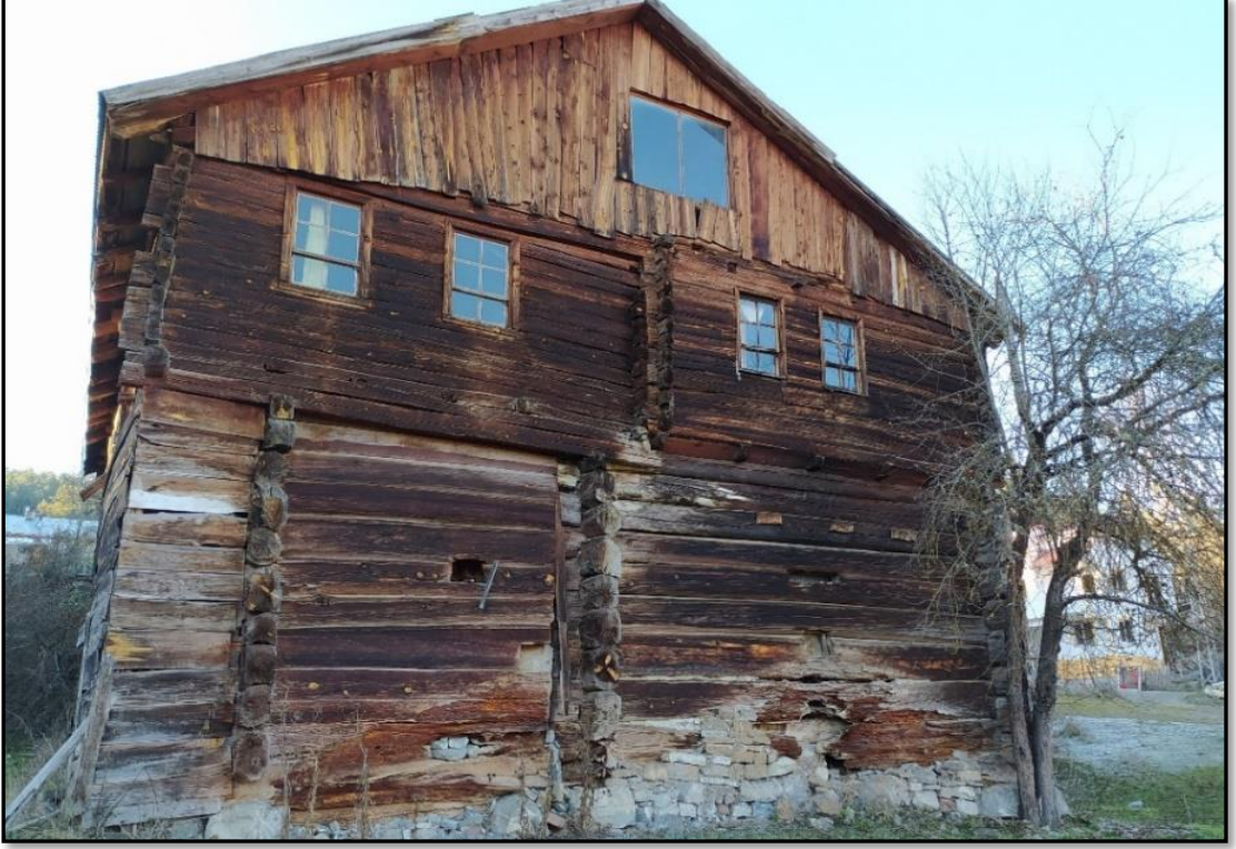
Fotoğraf 24. Oturma katı kurtboğaz, ahır katı karaboğaz geçme olarak inşa edilmiş geleneksel mesken, Gümürtler köyü.
