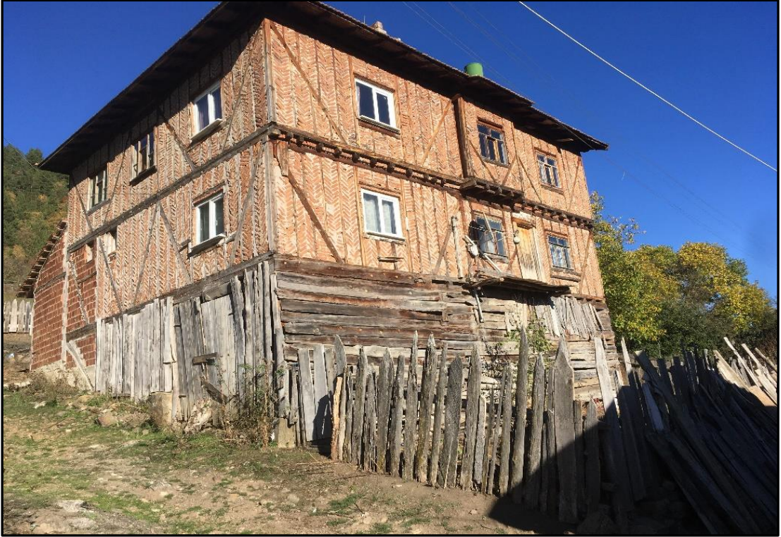
Fotoğraf 26. Ahşap çatma tekniği ile inşa edilmiş geleneksel mesken, Gümürtler Köyü.
