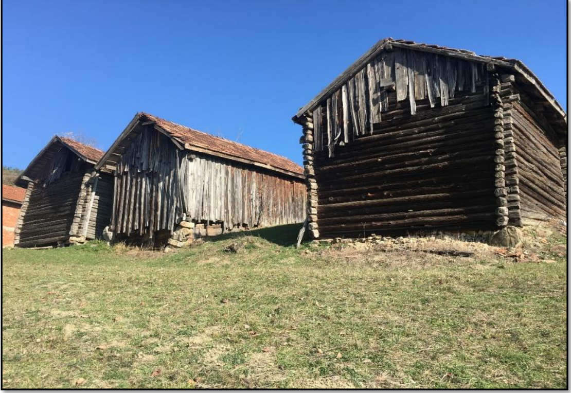
Fotoğraf 50. Karaboğaz geme yntemi ile yapılmıř ahřap yığma samanlıklar.
