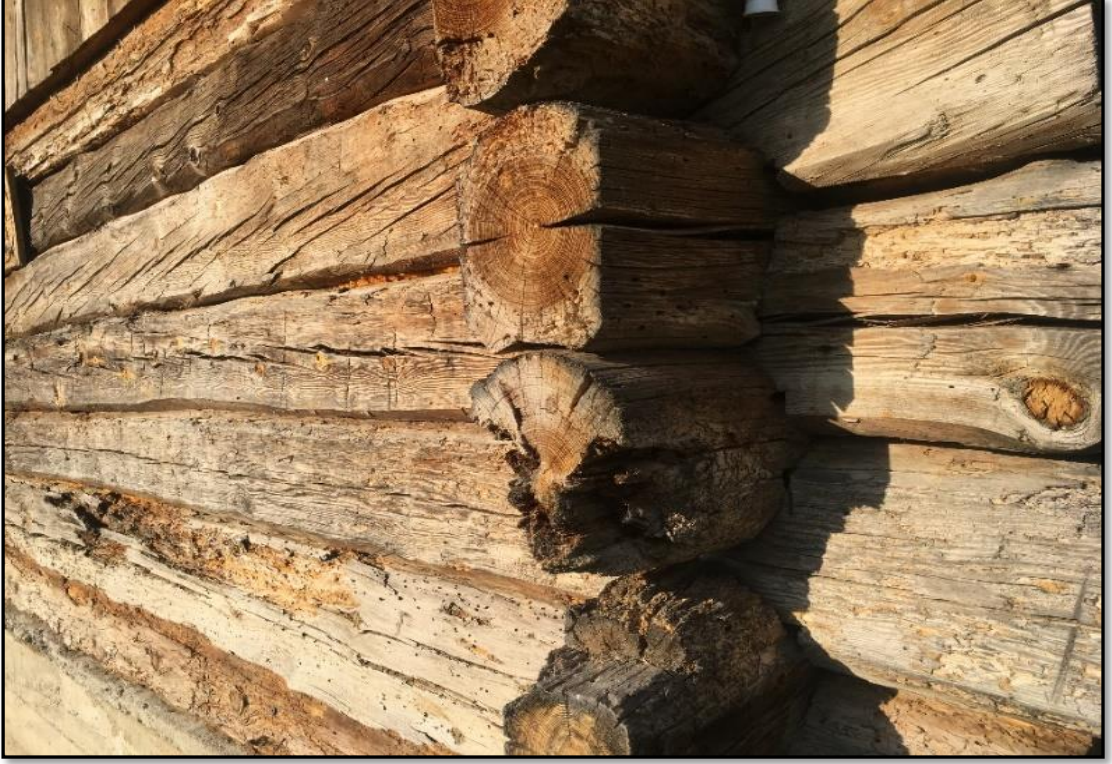
Fotoğraf 23. Araştırma sahasında karaboğaz geçme yöntemi ile yapılmış ambar duvarı.
