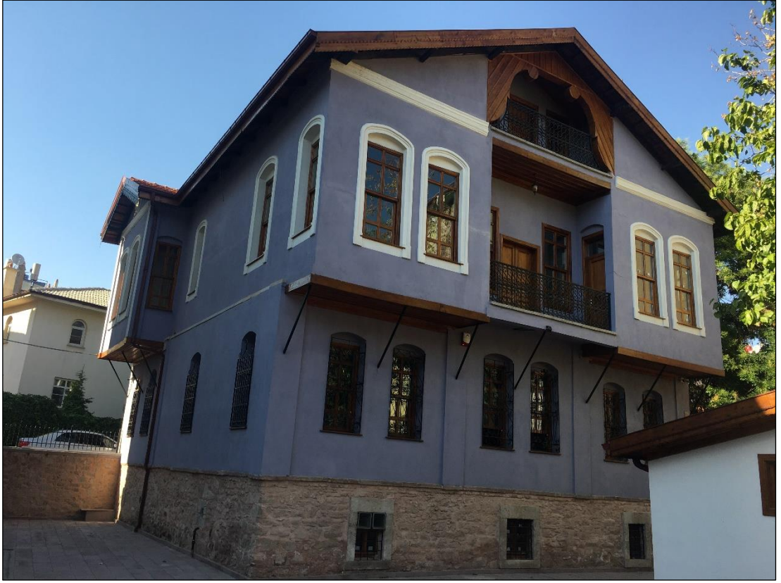
Şekil 5.46 Cenanyan Mektebi güney cephe görünüşü (Yağcı, 2020).
