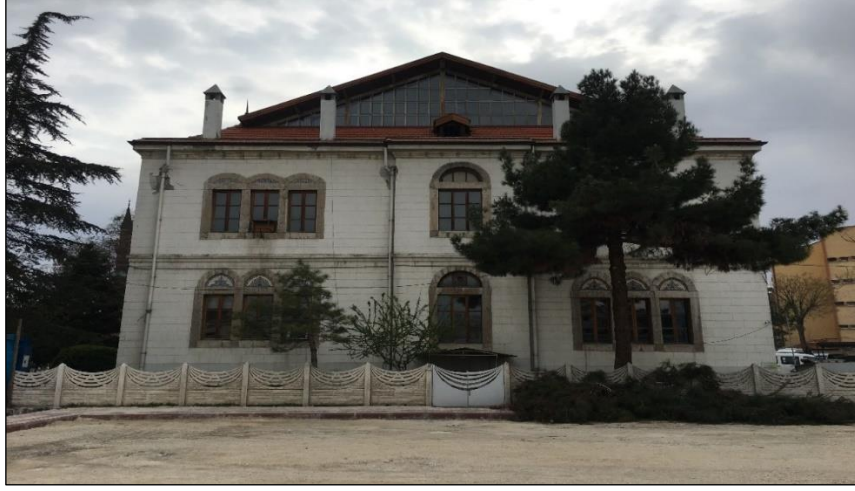
Şekil 3.70 Konya Sanayi Mektebi doğu cephesi fotoğrafı (Yağcı, 2020).
