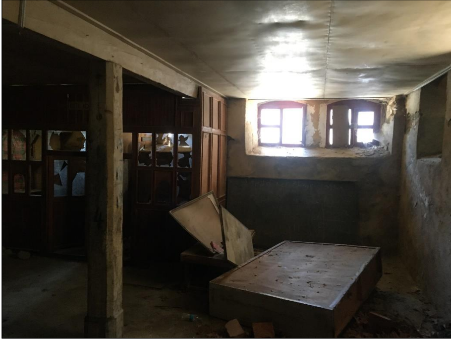
Şekil 5.93 Bodrum kat kantin mekânındaki ahşap kiriş (Yağcı, 2020).
