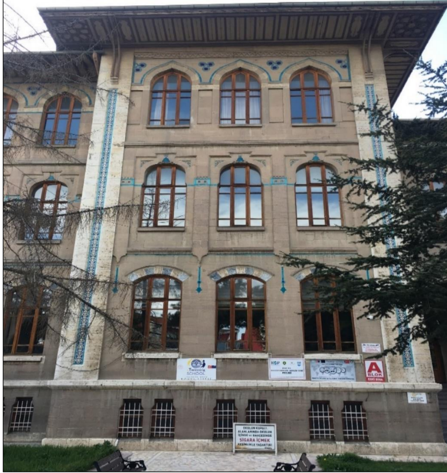
Şekil 3.44 Konya Darülmuallemi pencere görünüşleri (Yağcı, 2020).
