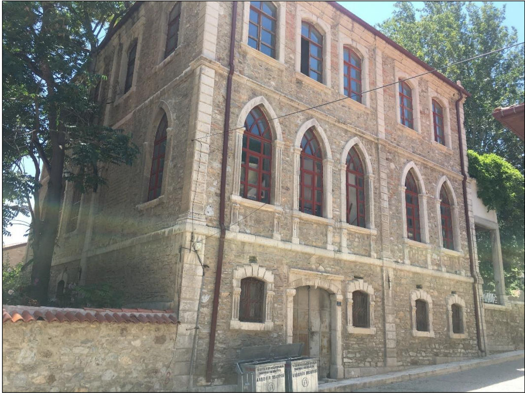
Şekil 5.86 Akşehir Ermeni Mektebi kuzeybatı cephesi (Yağcı, 2020).
