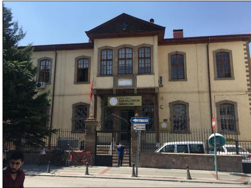
Şekil 5.101 Konya Fransız Erkek Mektebi güneydoğu cephesi (Yağcı, 2020).
