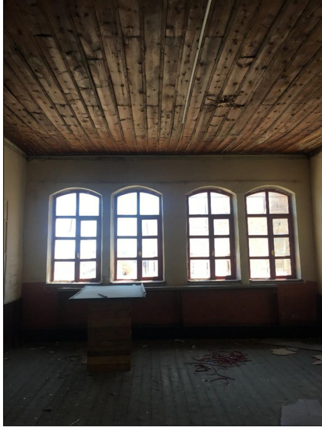
Şekil 5.82 Güneydoğu cephesine bakan diğer derslik mekânı (Yağcı, 2020).
