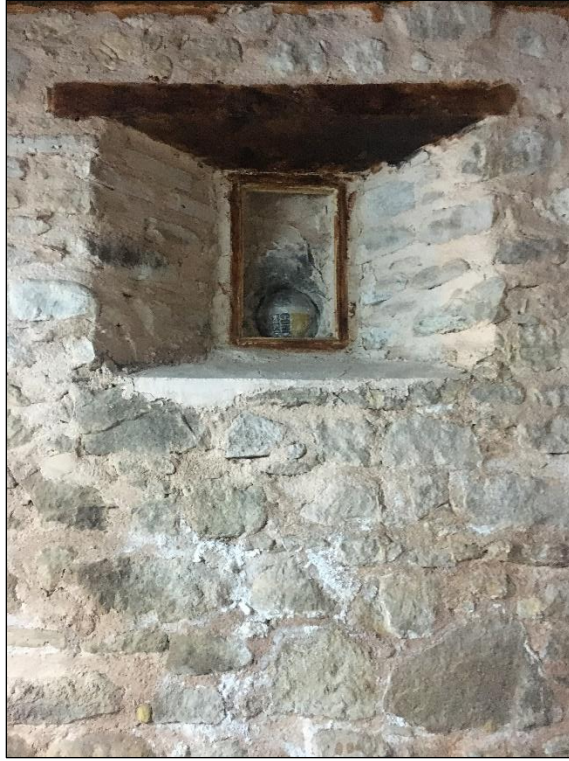
Şekil 5.22 Bodrum katın kuzeye bakan pencereleri (Yağcı, 2020).
