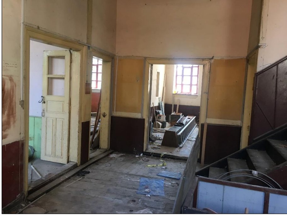
Şekil 5.71 Zemin kat giriş holü (Yağcı, 2020).
