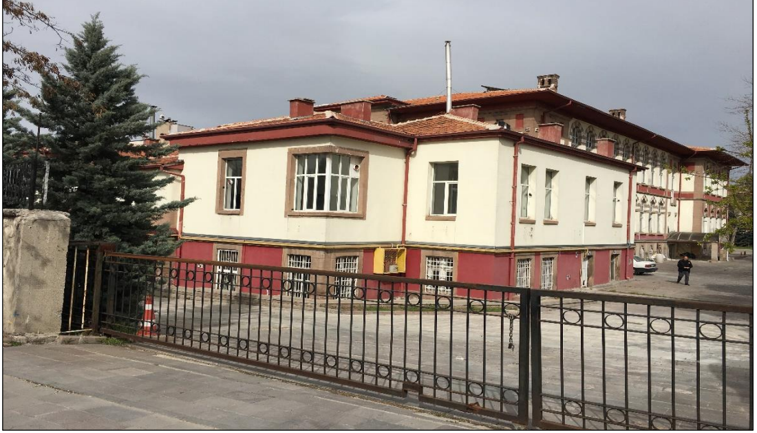
Şekil 3.51 Binanın batı cephesine yapılan eklenti (Yağcı, 2020).
