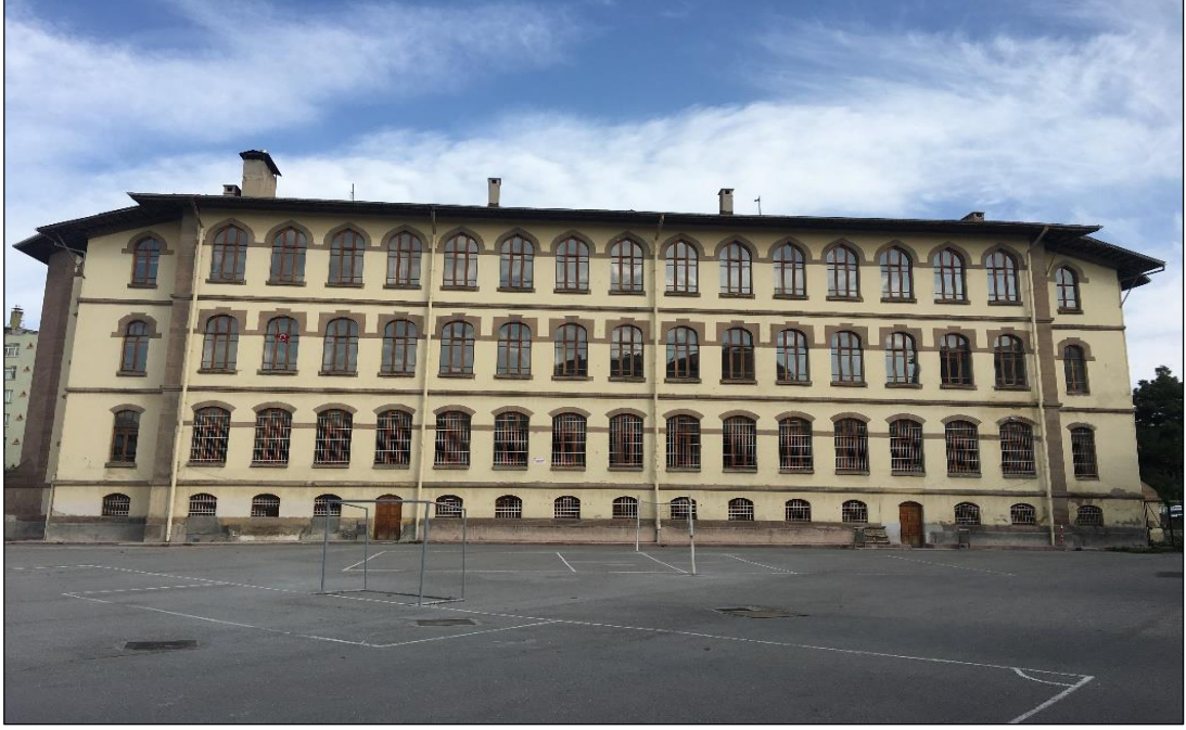
Şekil 3.48 Konya Darülmüallimin Mektebi arka cephesi (Yağcı, 2020).
