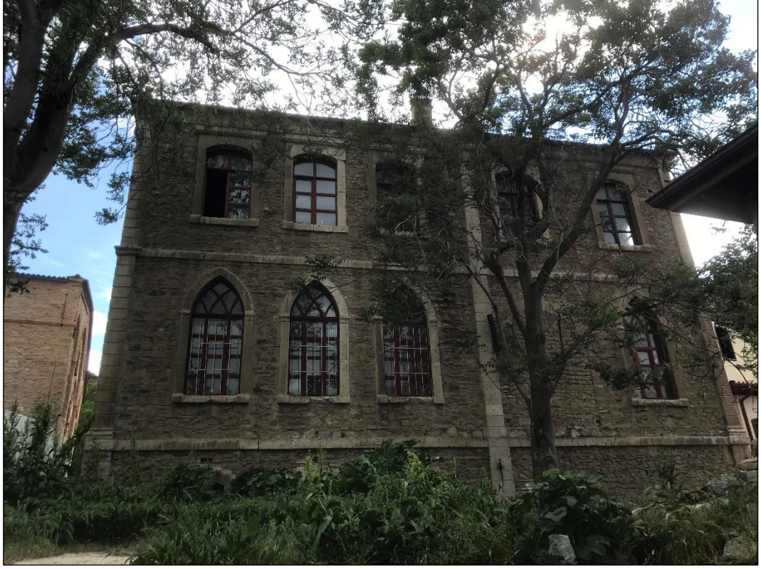
Şekil 5.91 Akşehir Ermeni Mektebi kuzeydoğu cephesi (Yağcı, 2020).
