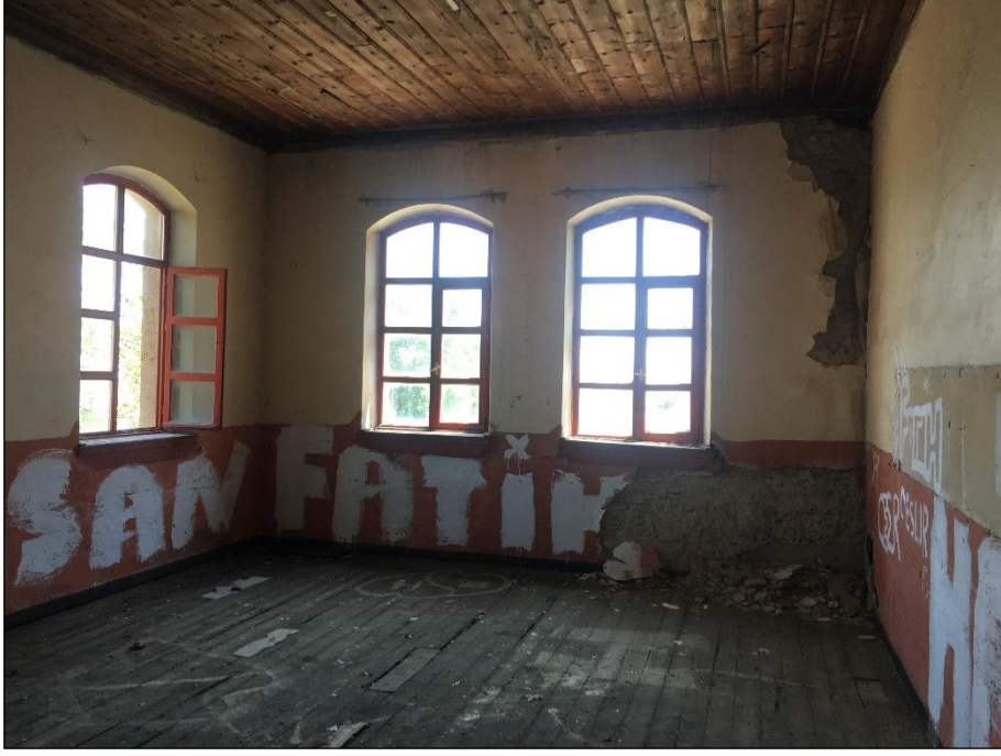
Şekil 5.81 Güneydoğu cephesine bakan derslik mekânı (Yağcı, 2020).
