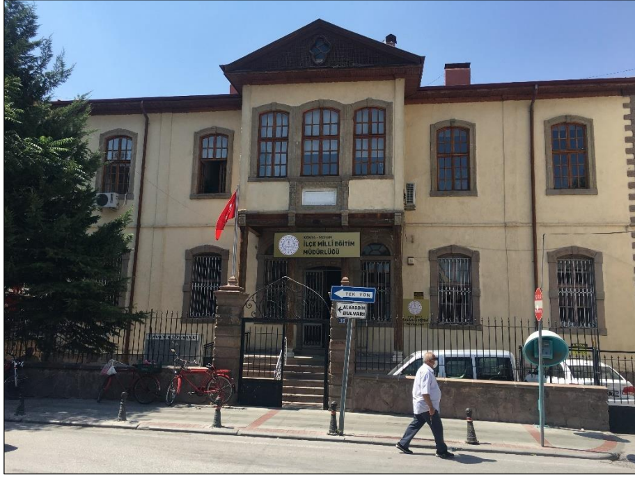
Şekil 5.137 Fransız Erkek Mektebi güneydoğu cephesi (Yağcı, 2020).
