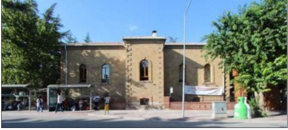
Şekil 3.32 Niğde Darülmuallimin Mektebi batı cephesi (Toptaş, 2017).
