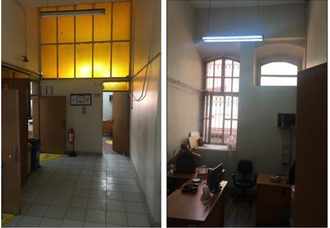
Şekil 5.117 Fransız Erkek Mektebi santral odasının görünüşü (Yağcı, 2020).
