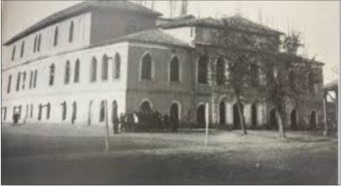
Şekil 3.16 Konya İdadi Mektebi binası (Sarıçelik, 2010).
