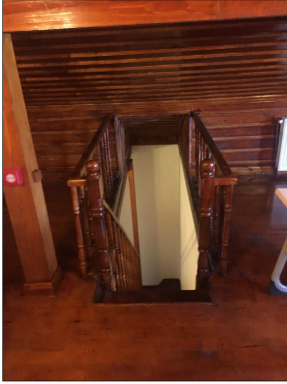
Şekil 5.41 Çatı katına çıkış merdiveni (Yağcı, 2020).
