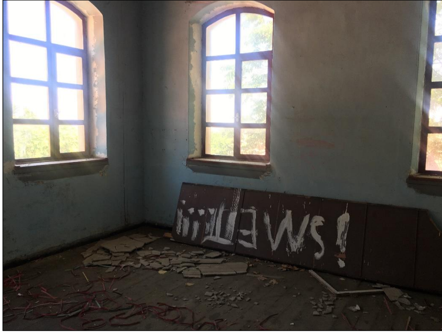
Şekil 5.83 Kuzeydoğu cephesine bakan laboratuvar mekânı (Yağcı, 2020).
