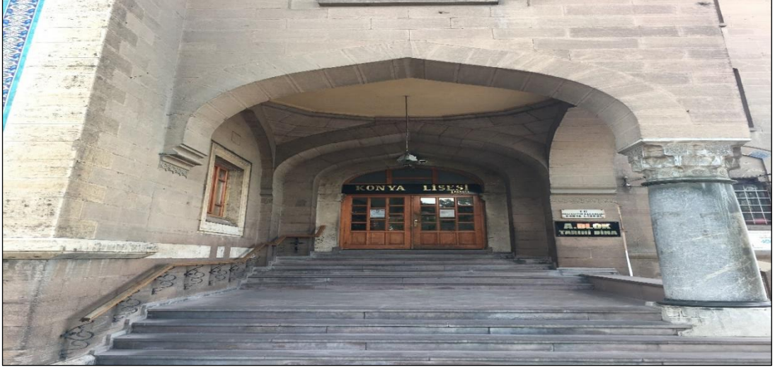
Şekil 3.38 Konya Darülmüallimini giriş saçağı ve merdiveni (Yağcı, 2020).
