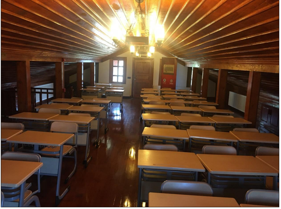
Şekil 5.55 Cenanyan Mektebi çatı katı tavan ve döşeme görünüşü (Yağcı, 2020).
