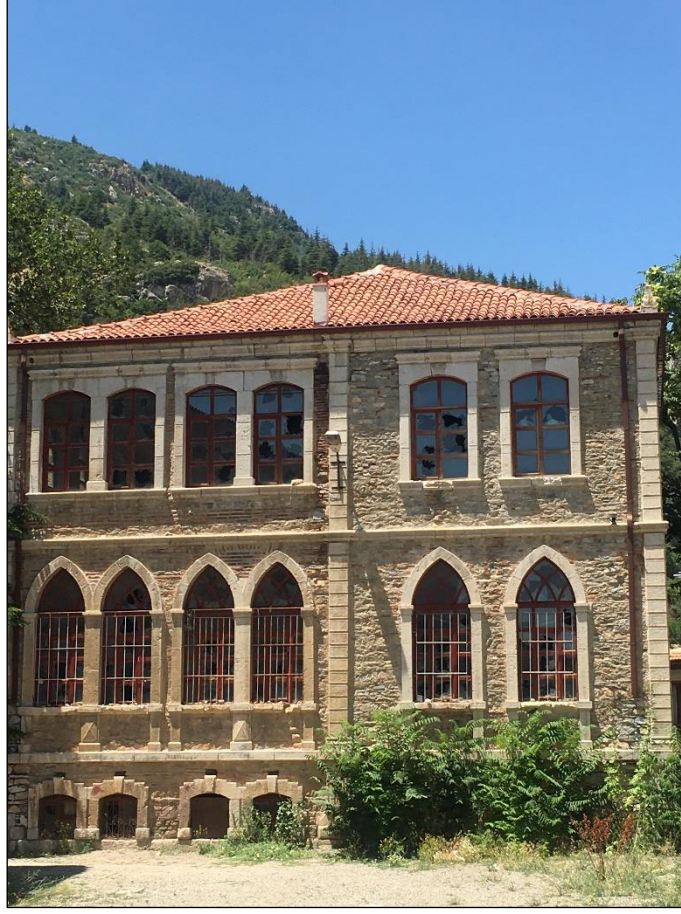
Şekil 5.89 Akşehir Ermeni Mektebi güneydoğu cephesi (Yağcı, 2020).
