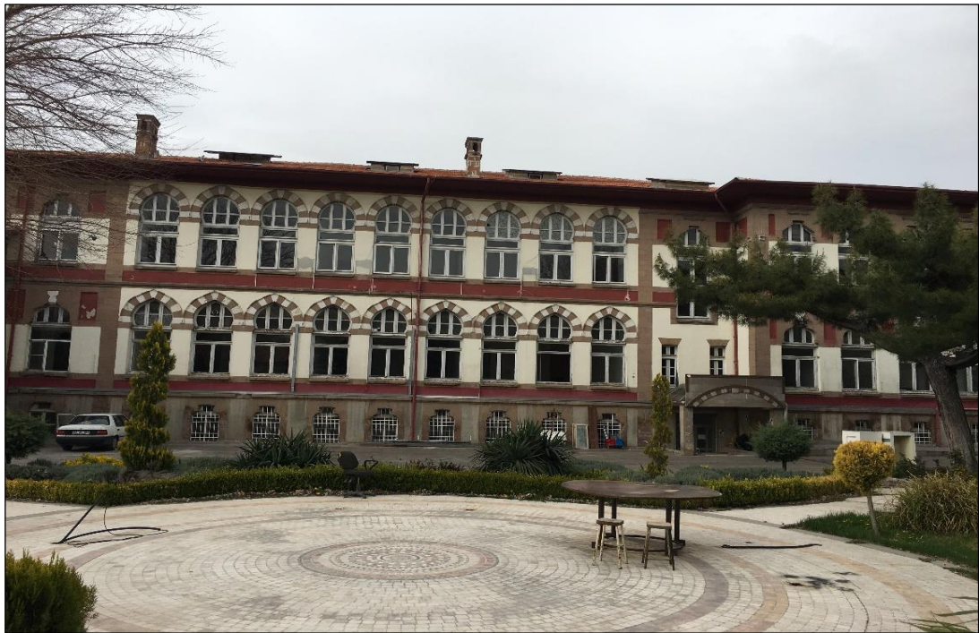
Şekil 3.60 Darülmüallimat güney cephesi (Yağcı, 2020).
