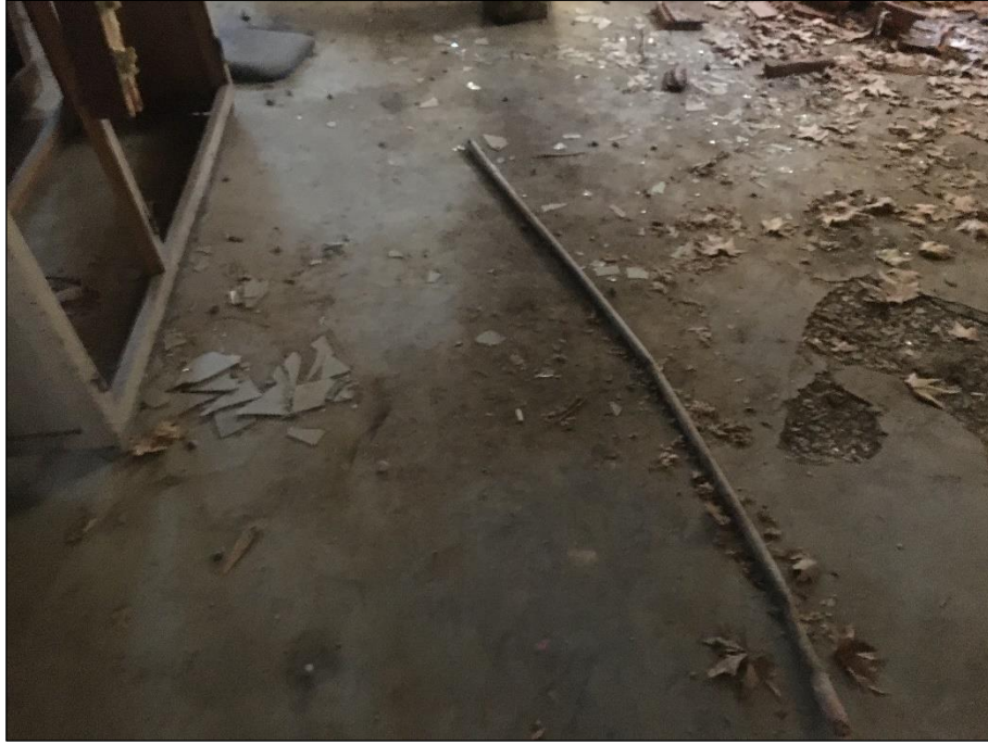
Şekil 5.96 Bodrum kat zemin kaplaması görünüşü (Yağcı, 2020).
