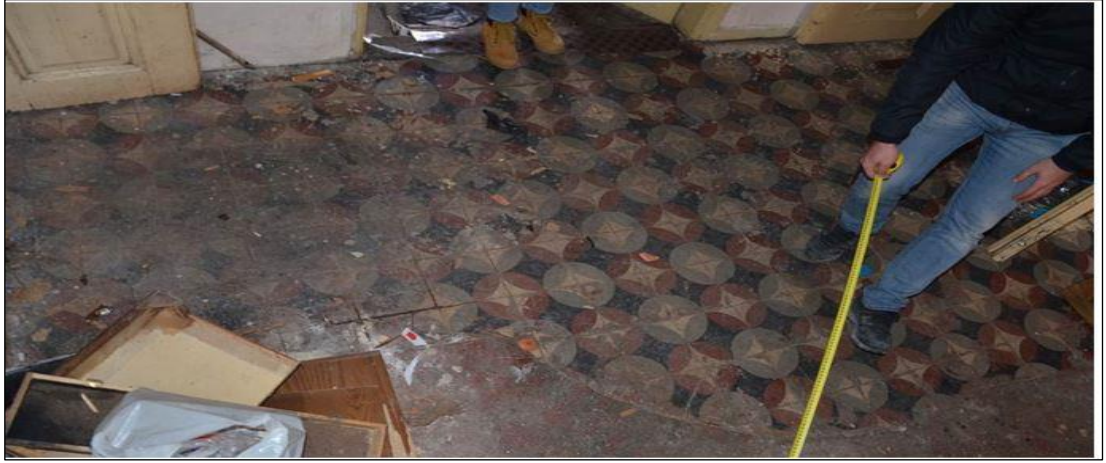
Şekil 5.8 Cenanyan Mektebi'nin kaldırılan dairesel merdivenin izi (Yağcı, 2019).
