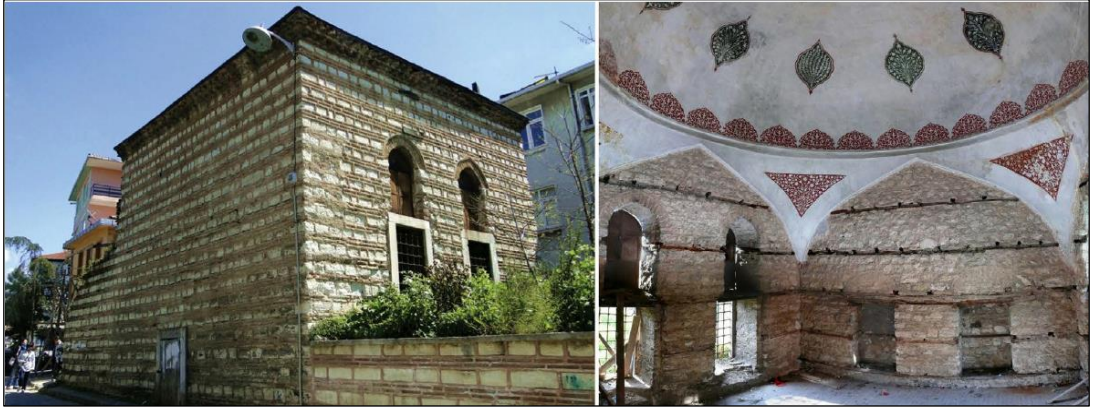
Şekil 2.14 İstanbul Atik Valide Sıbyan Mektebi (Balcan, Binan 2019).
