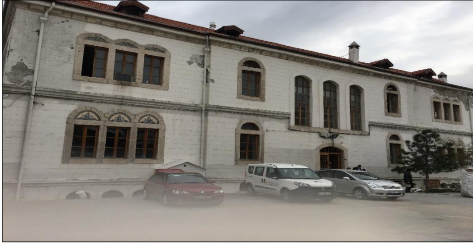
Şekil 3.74 Konya Sanayi Mektebi kuzey cephe fotoğrafı (Yağcı, 2020).
