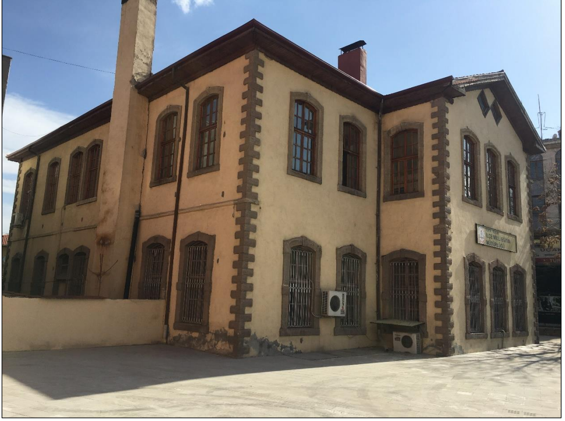
Şekil 5.143 Fransız Erkek Mektebi kuzeydoğu cephesi (Yağcı, 2020).
