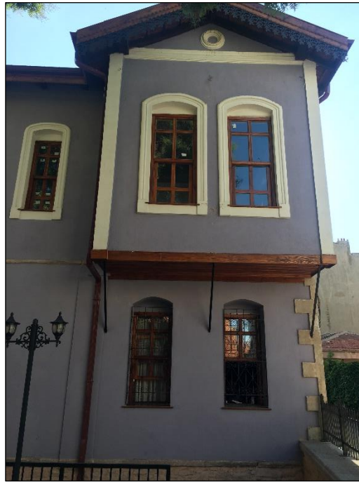
Şekil 5.49 Doğu cephesindeki cumbanın görünüşü (Yağcı, 2020).
