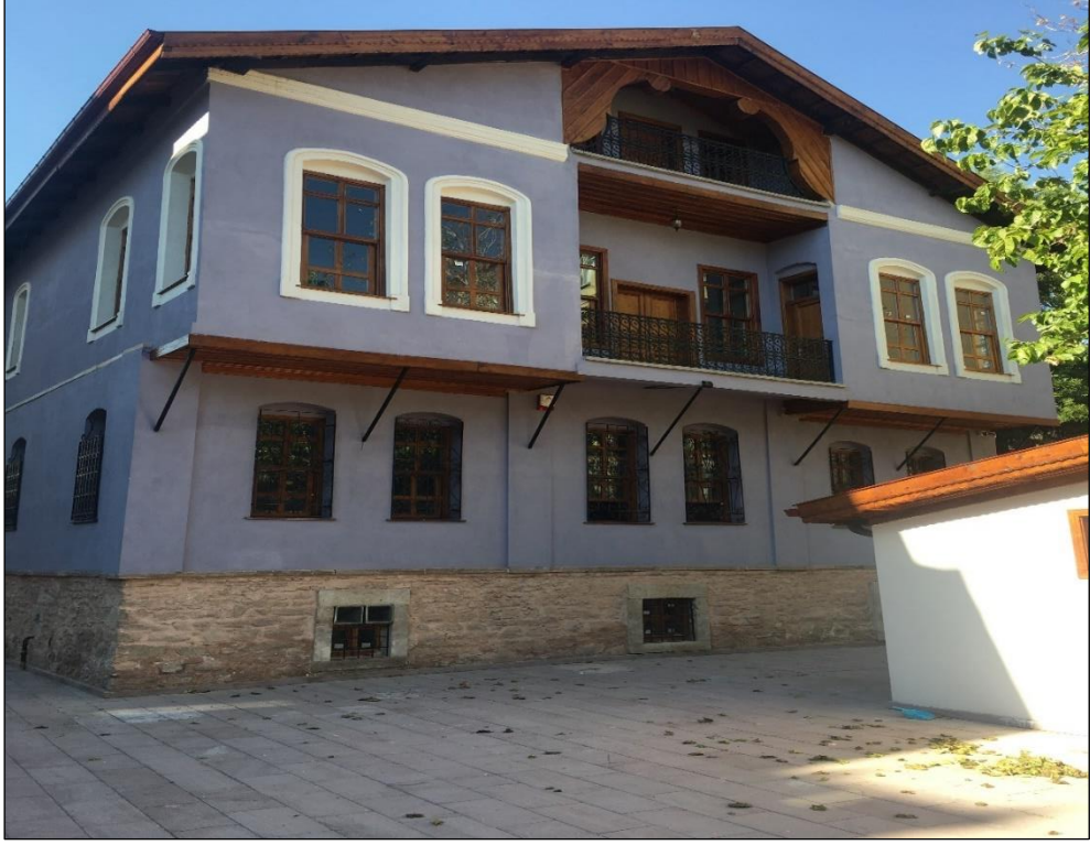
Şekil 5.15 Cenanyan Mektebi 5. dönem güney cephe (Yağcı, 2020).
