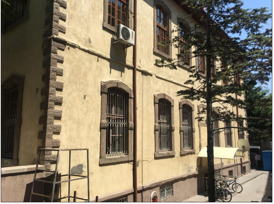
Şekil 5.141 Fransız Erkek Mektebi güneybatı cephesi (Yağcı, 2020).
