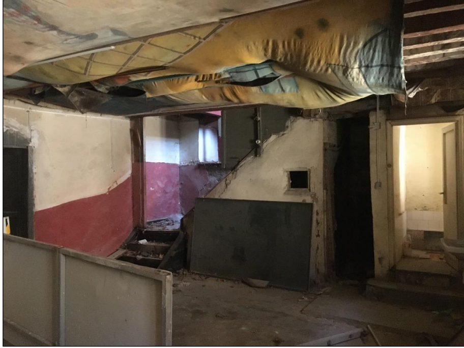
Şekil 5.65 Akşehir Ermeni Mektebi bodrum kat koridoru (Yağcı, 2020).
