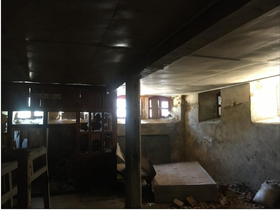
Şekil 5.66 Akşehir Ermeni Mektebi kantin mekânı (Yağcı, 2020).
