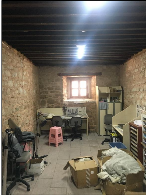
Şekil 5.24 Bodrum kat tavanı ahşap kirişlemeler (Yağcı, 2020).
