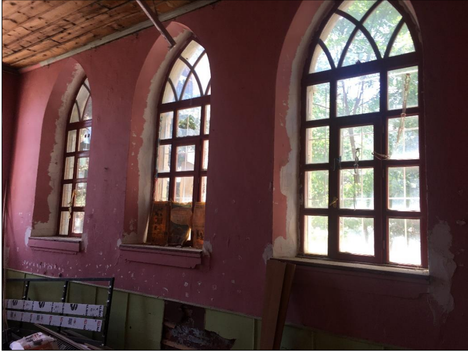
Şekil 5.74 Güneybatı cephesine bakan derslik mekânı (Yağcı, 2020).
