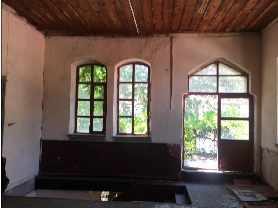
Şekil 5.79 Birinci kattan balkona açılan kapı (Yağcı, 2020).
