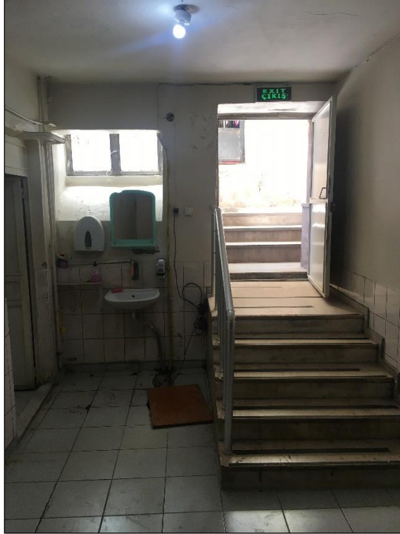
Şekil 5.104 Konya Fransız Erkek Mektebi bodrum kat giriş holü (Yağcı, 2020).
