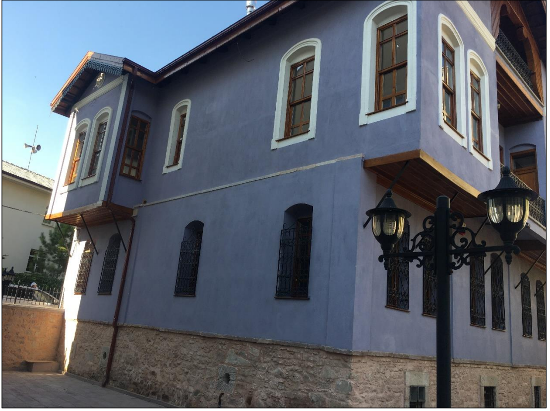
Şekil 5.51 Cenanyan Mektebi batı cephesi görünüşü (Yağcı, 2020).
