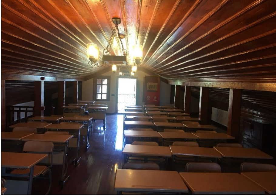
Şekil 5.42 Çatı Katı ahşap kiriş ve kolonlar (Yağcı, 2020).
