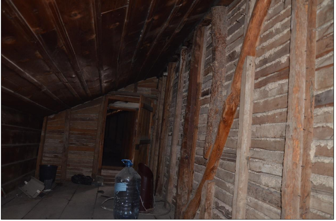
Şekil 5.53 Cenanyan Mektebi çatı katı duvar görünüşü (Yağcı, 2018).
