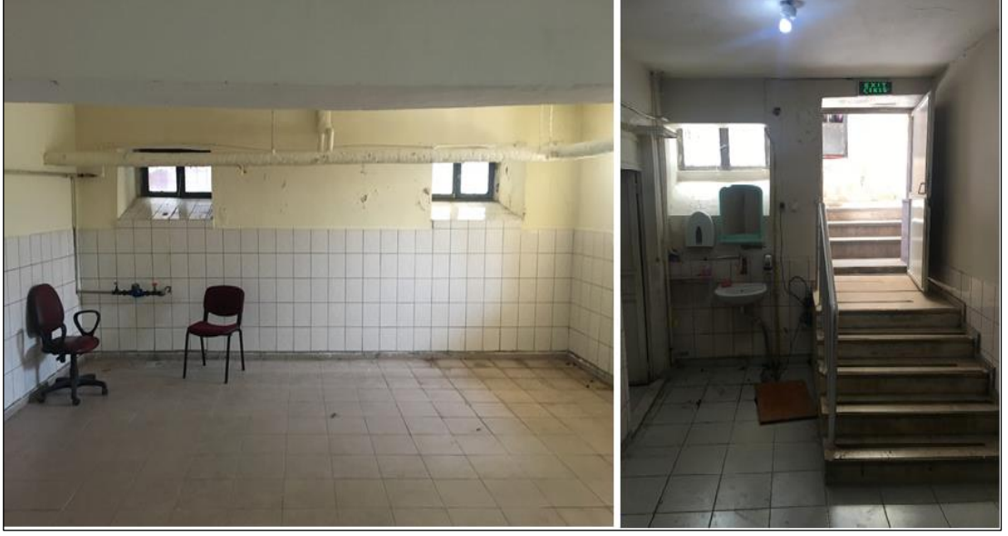
Şekil 5.144 Bodrum kat arşiv ve giriş holü görünüşü (Yağcı, 2020).
