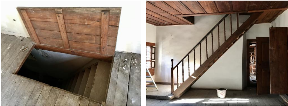
a) Asma kat ile birinci kat arasındaki merdiven.
