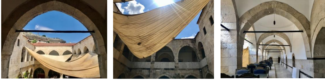
Şekil 5.3. Cinci Hanı'ndaki avluya açılan revaklar.
