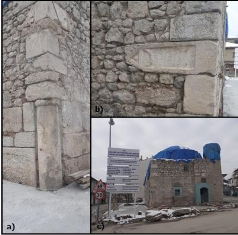
Fotoğraf 39: Hacı İshak Cami'nde Yapılan Restorasyon Çalışması
