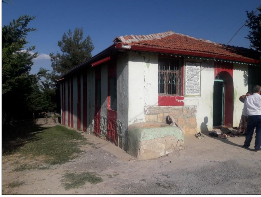
Fotoğraf 74: Zile Acısu Köyü'nde Bulunan Anşa Bacı Türbesi
