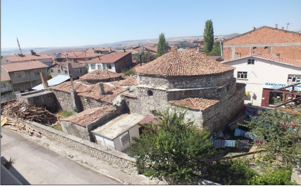
Fotoğraf 53: Zile Merkez’de Bulunan Yeni Hamam’dan Bir Görünüm
