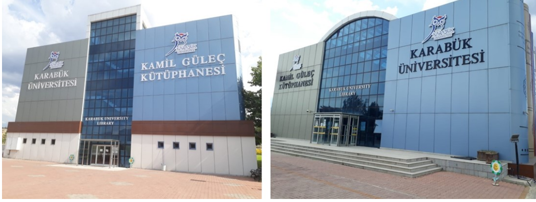
Şekil 4.6. Kamil Güleç Kütüphanesi kuzey ve güney cephesi.
