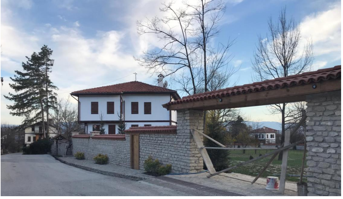
Şekil 4.8. Kentsel Sit Bölgesi duvar uygulaması ve su arkı örneği (Ulukaya, 2020).
