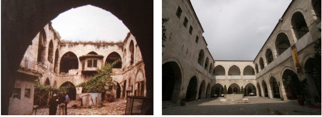
Şekil 4.3. Safranbolu Cinci Hanı restorasyonu öncesi ve sonrası iç görünüm (Safranbolu Belediyesi Arşivi, 2019).
