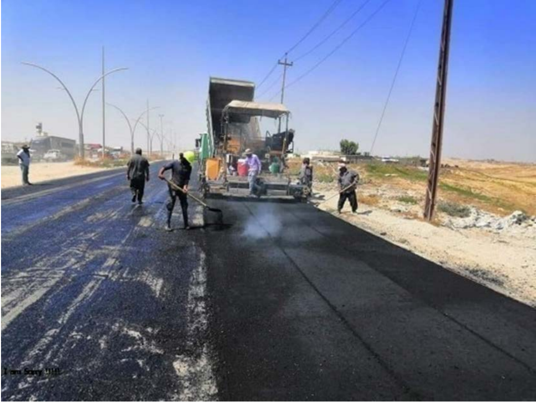
Fotoğraf 5. Yolların Asfaltlaması
