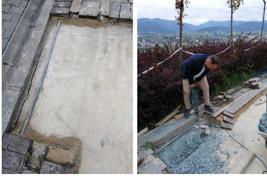
Şekil 6.7. Pandül sisteminin ana iskeletinin zemine sabitlenebilmesi için yapılan hazırlık çalışmaları.
