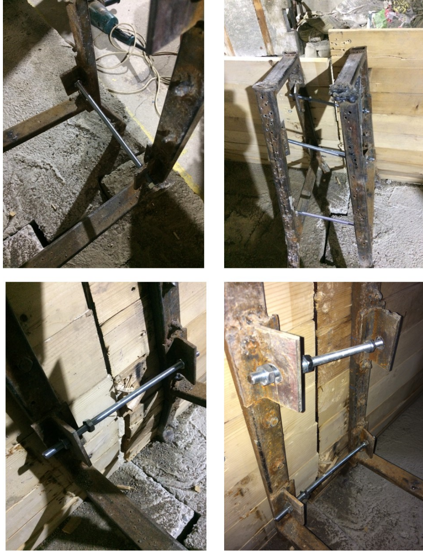
Şekil 3.16. Metal ızgaraların birbirlerine bağlanmasını sağlayan birleştirme tipi.
