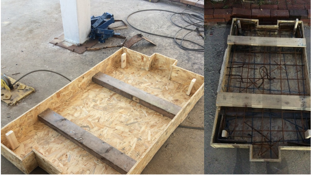
Şekil 3.14. Beton tablaların kalıplarının hazırlanması.
