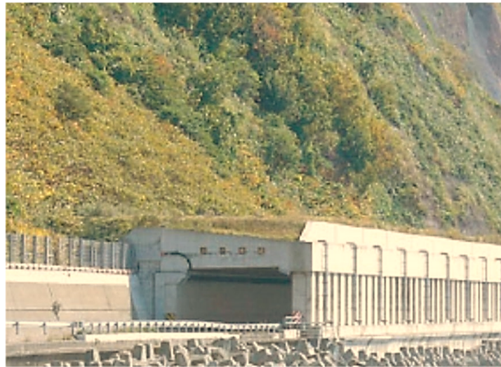
Şekil 3.10. Kaya koruma tüneline kum yastık kullanımı [84].
