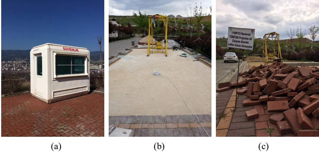
Şekil 6.6. Kontrol odası (a), pandül sisteminin kurulacağı zeminin hazırlanışı (b,c).
