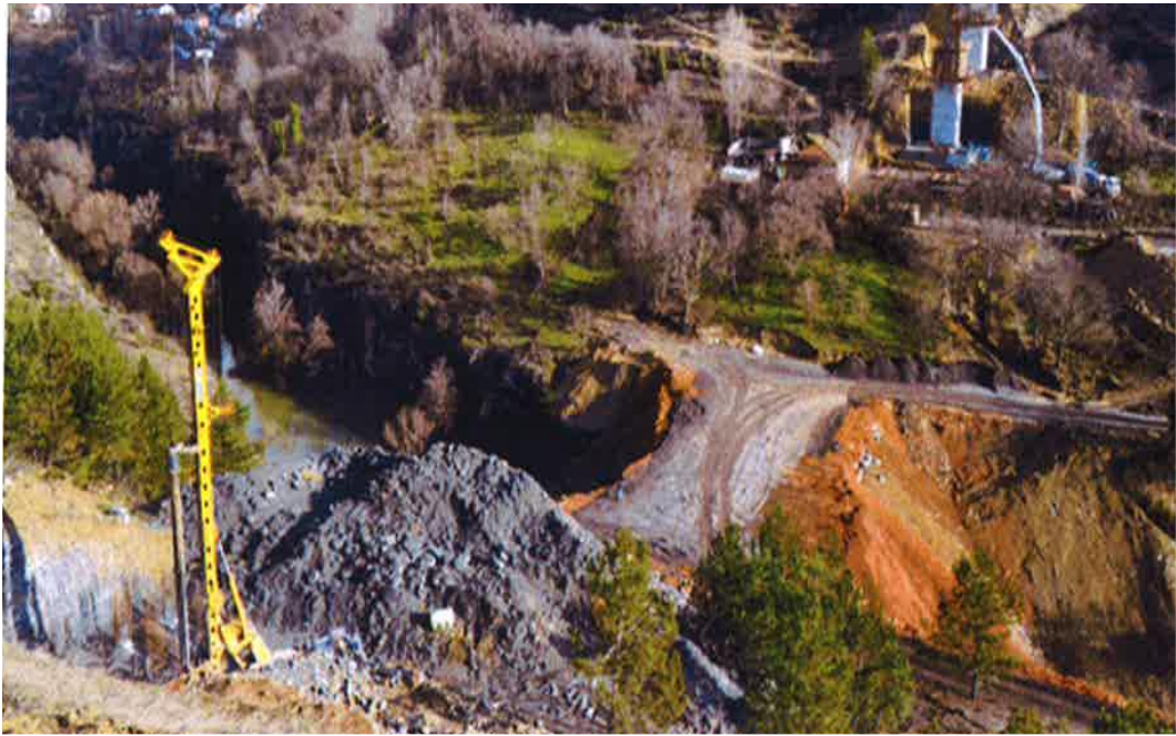
Şekil 1.4. Dere yatağına izinsiz yapılan dolgu (DSİ, 2016).
