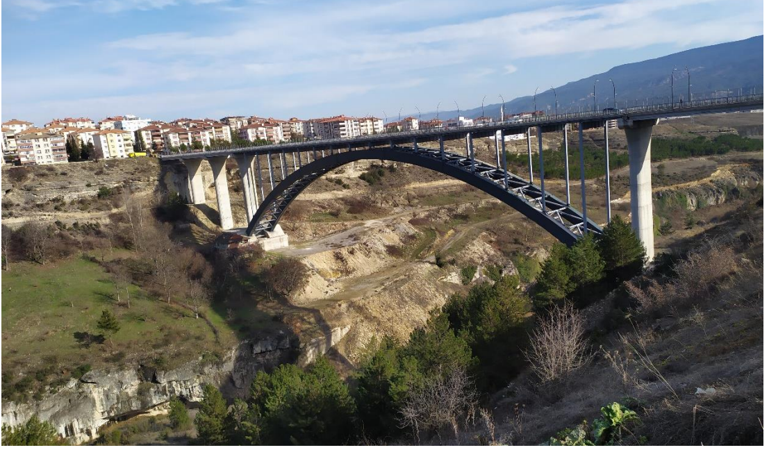
Şekil 2.6. Bulak Kanyonu Köprüsü.
