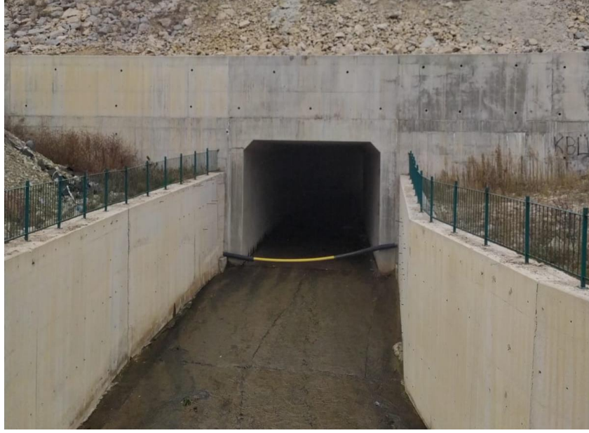
Şekil 1.8. Karabük-Kastamonu Karayolu altında bulunan menfezin mansap tarafı.
