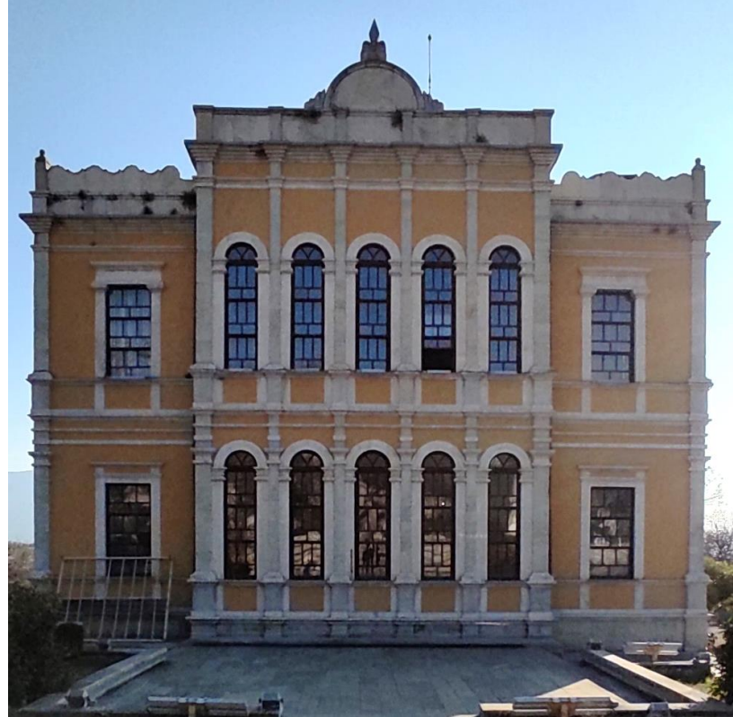
Şekil 4.12. Safranbolu Hükûmet Konağı arka cephe [Özmen, 2020]
