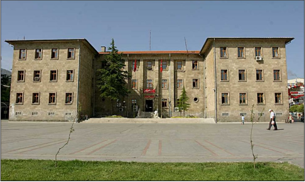
Fotoğraf 35. Isparta Merkez’de Yer Alan Valilik Binası
