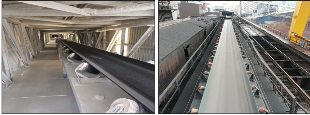
Şekil 2.2. Endüstriyel tesiste yer alan kapalı ve açık bantlı konveyör galerisi.
