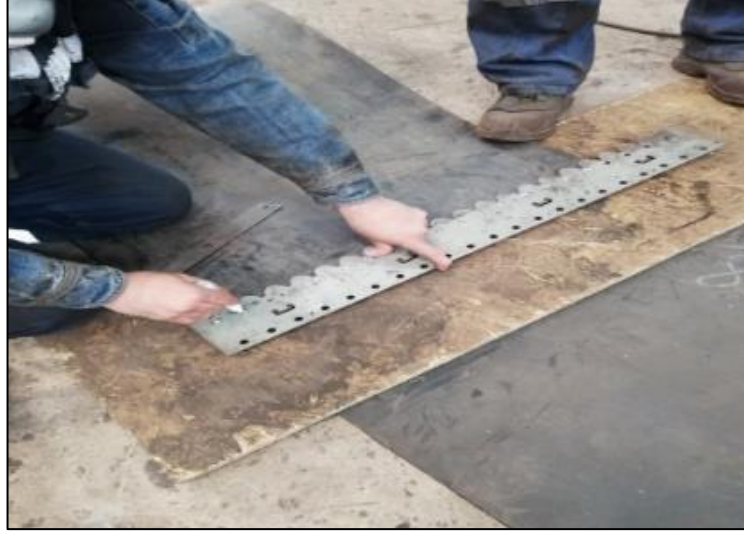
Şekil 3.33. Mekanik ekleme şablon ve delik merkezlerinin ayarlanması.
