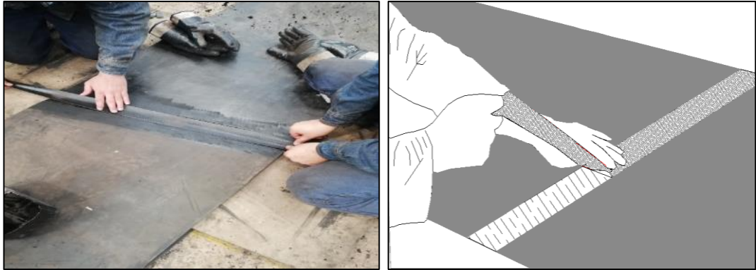
Şekil 3.25. Üst kapama kauçuğunun yapıştırılması.
