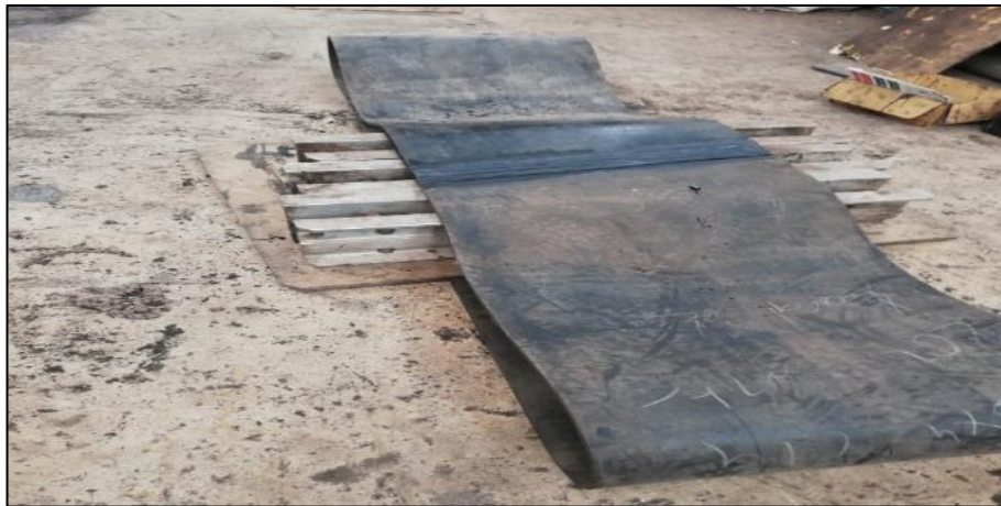
Şekil 3.27. Alt vulkanize traverslerin yerleştirilmesi.
