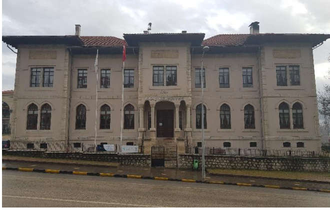
a) Kuzey cephesi genel görünüm.
