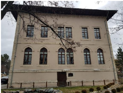
a) Batı cephesi genel görünüm.
