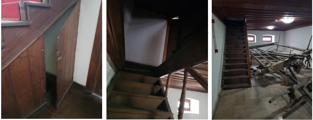
Şekil 4. 136. Zemin kat merdiven altından ulaşılan bodrum kat merdiveni.
