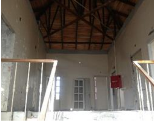
a) Yeni işlev öncesi çatı sistemi.
