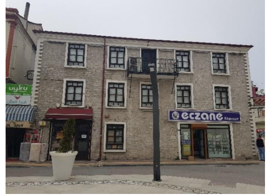
b)Yeni işlev sonrası sol yan cephe.
