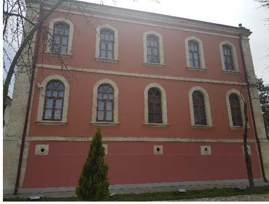
a) Kuzey cephe.
