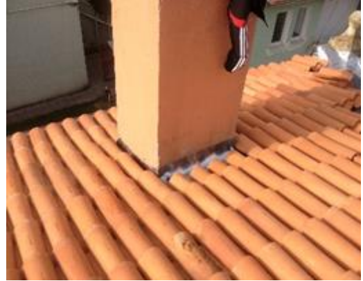
b) Yeni işlev sonrası çatı kaplaması.
