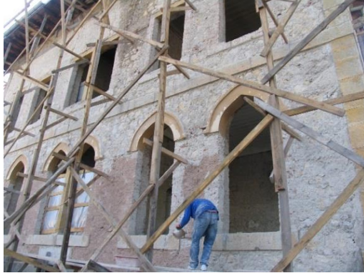
a) Restorasyon aşaması (A.B.O.T.A.).
