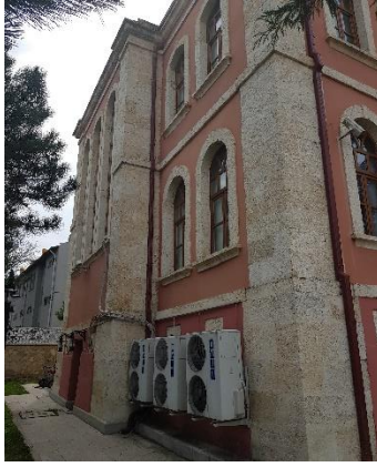
a) Kuzey cephe.
