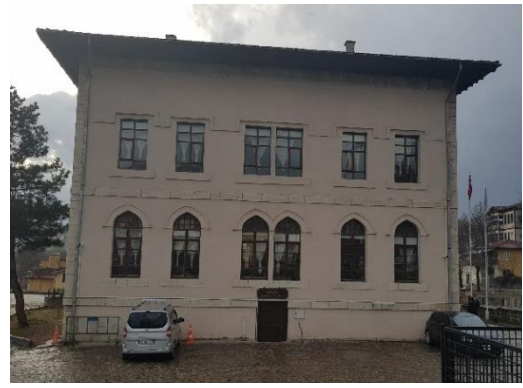
b) Doğu cephesi genel görünüm.
