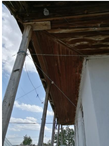
Şekil 5.12. Balkon üzerindeki tavan görünüşü
