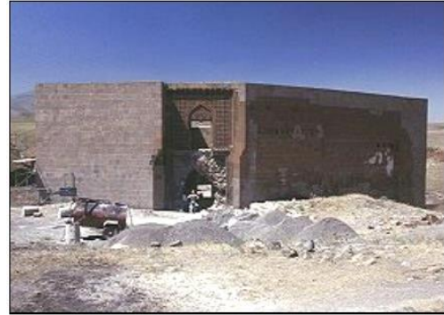
d) Giriş cephesi restorasyon çalışması
