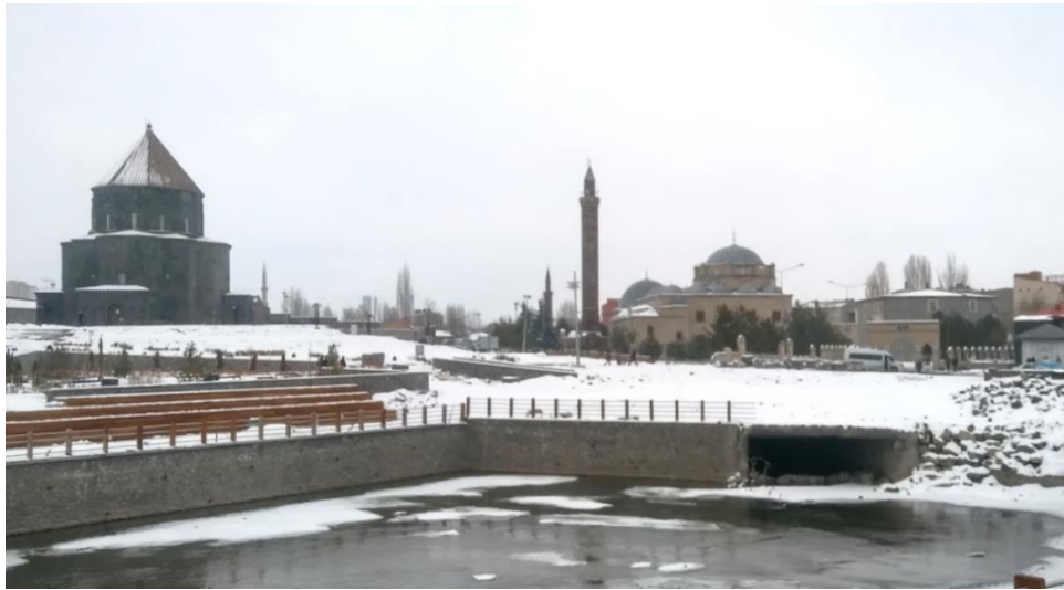
Şekil 2.6. Hasan Harakani Cami ve Kars 12 Havariler Kilisesi görünüşü
