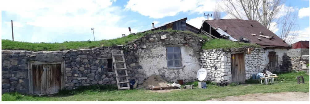
Şekil 4.16. Türkay Othan Evi güneydoğu cephe görünüşü
