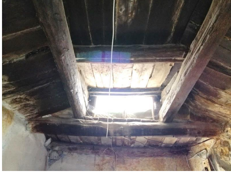
Şekil 4.19. Erdinç Özbey Evi koridor tavan görünüşü
