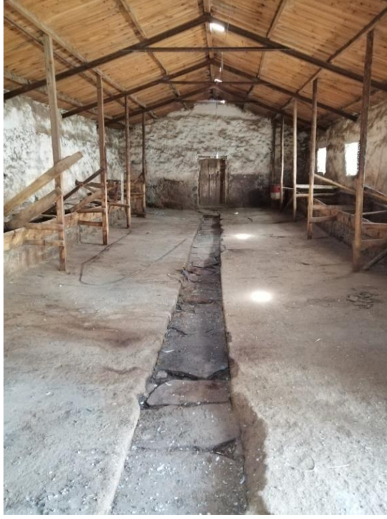
Şekil 5.13. Ahır içerisinden görünüş
