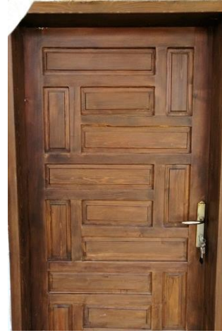
b) Kapı görünüşü
