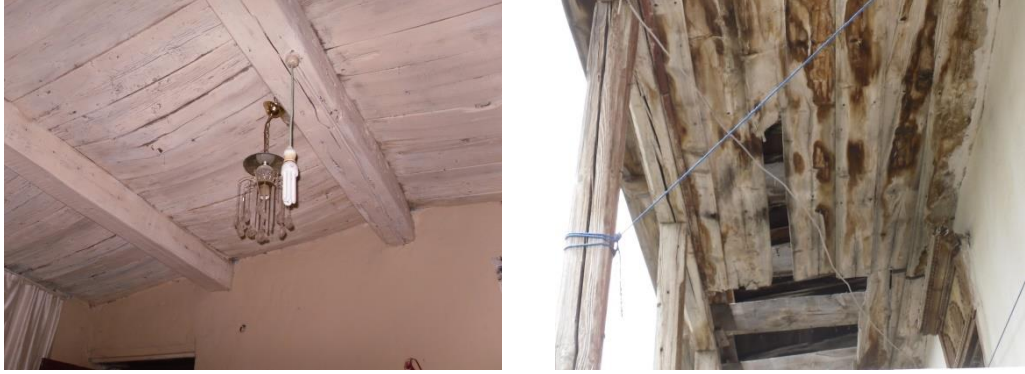
a) Odanın Tavanından Görünüş
