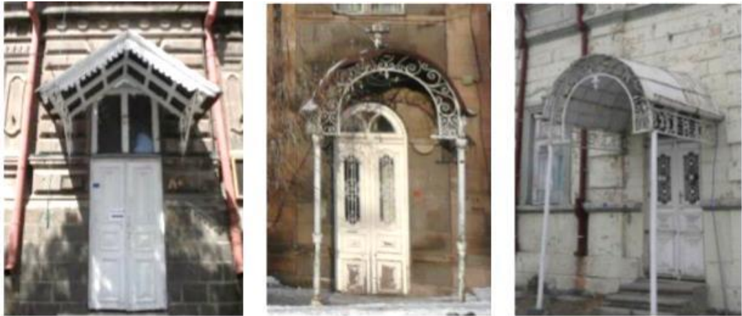
Şekil 2.20. Giriş saçakları ve üzerinde yer alan ahşap veya metal süslemeler [20].
