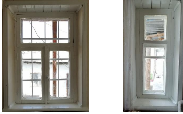
Şekil 5.9. Ahşap pencerelerin içeriden görünüşleri
