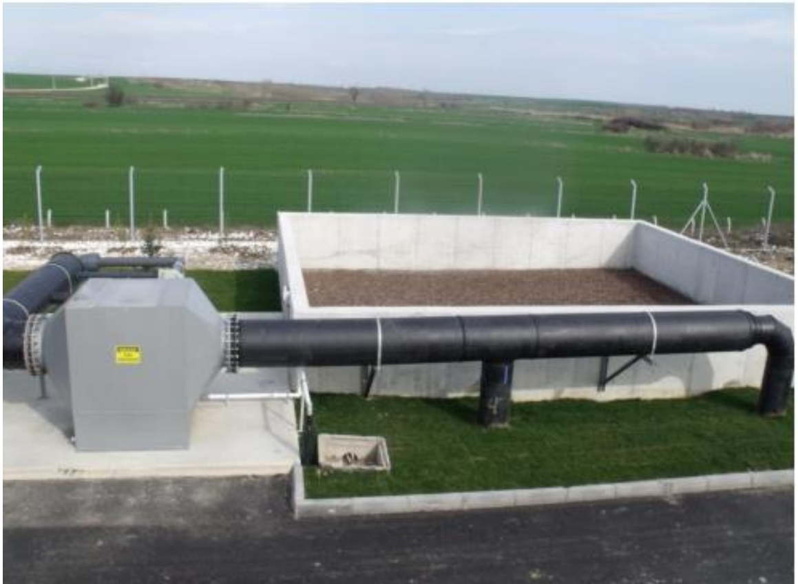
Şekil 4. 48. Koku kontrol sistemi.
