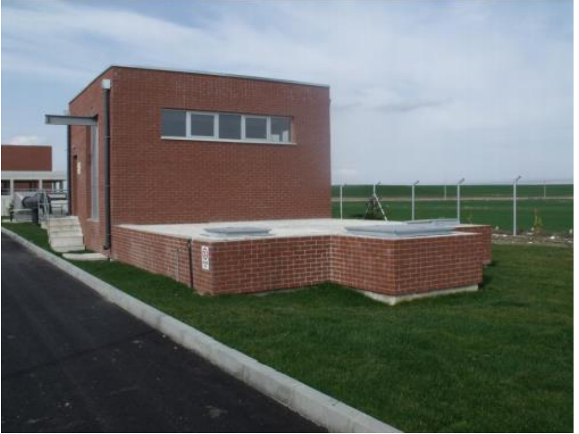
Şekil 4. 57. Yıkama ve yangın suyu deposu ve pompa istasyonu.
