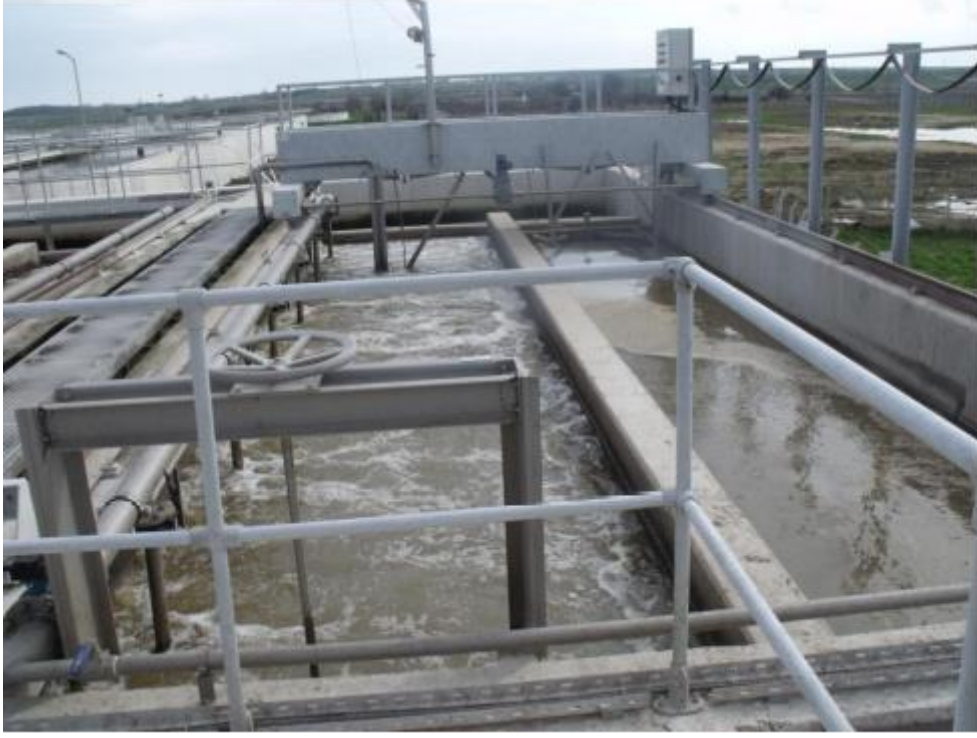
Şekil 4. 9. Havalandırmalı kum ve yağ tutucu.
