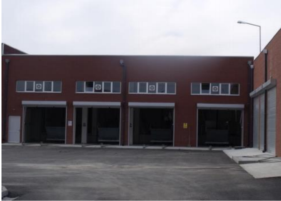
Şekil 4. 5. Ön arıtma ünitesi binası.
