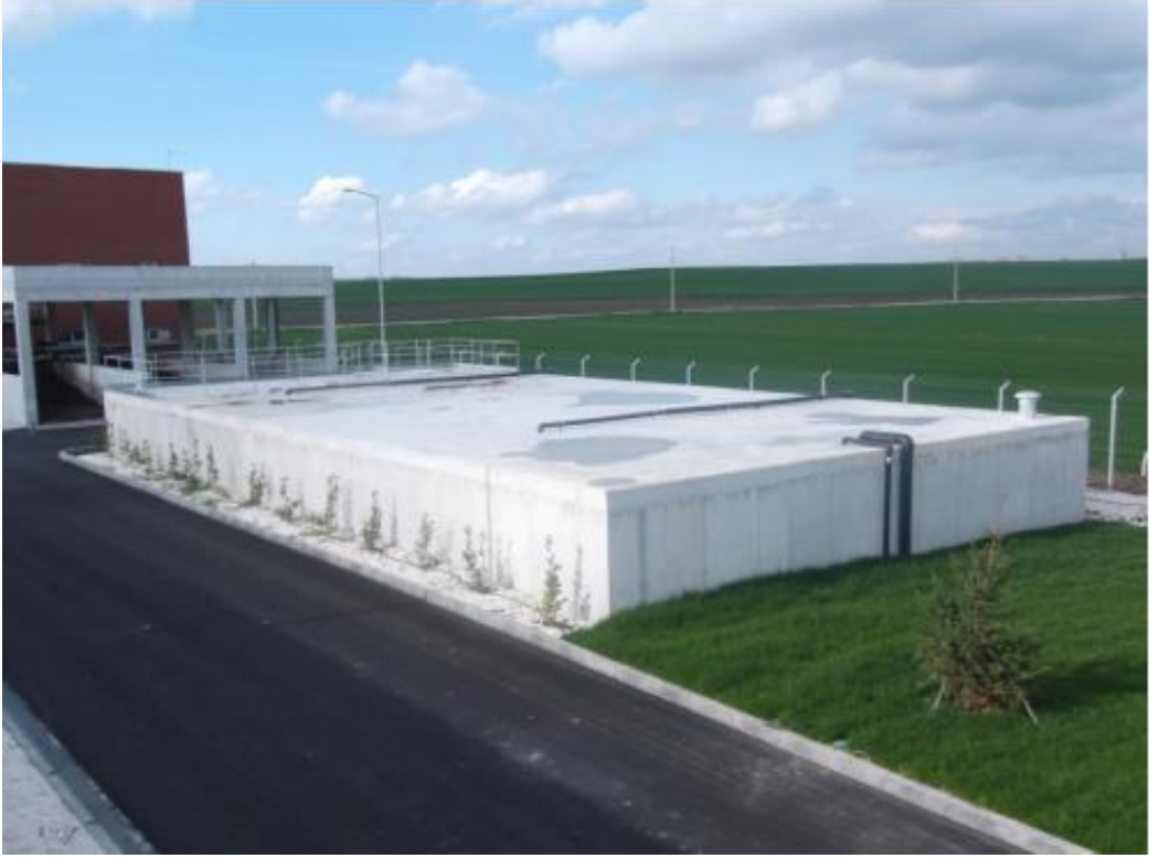
Şekil 4. 18. Çamur depolama tankı.
