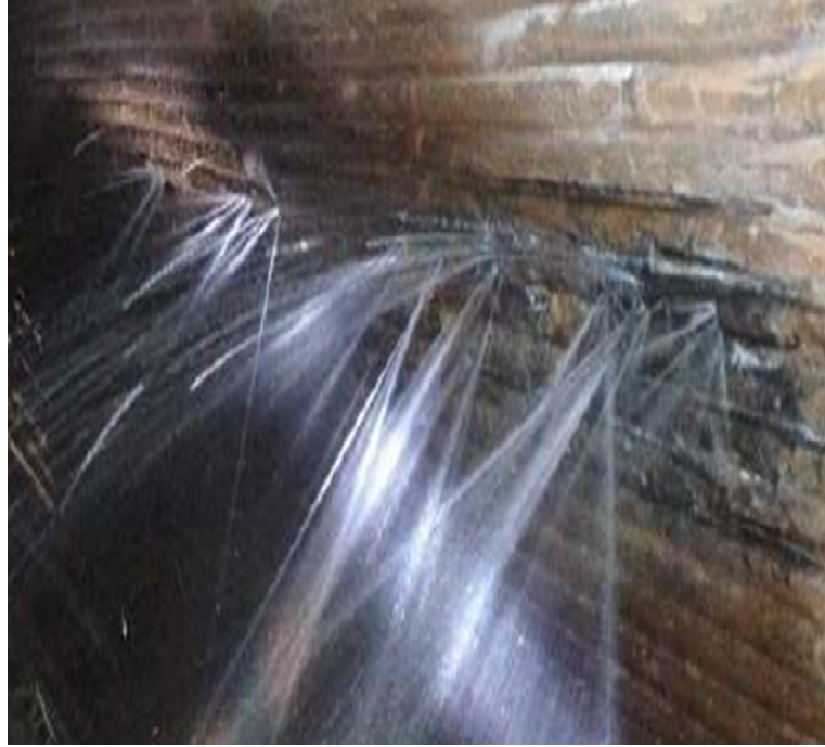
Şekil 4.15. Kardemir A.Ş. BOF flux şutun planlı bakım duruşlarında yapılan kontrollerde gözlenen aşınma görüntüsü.
