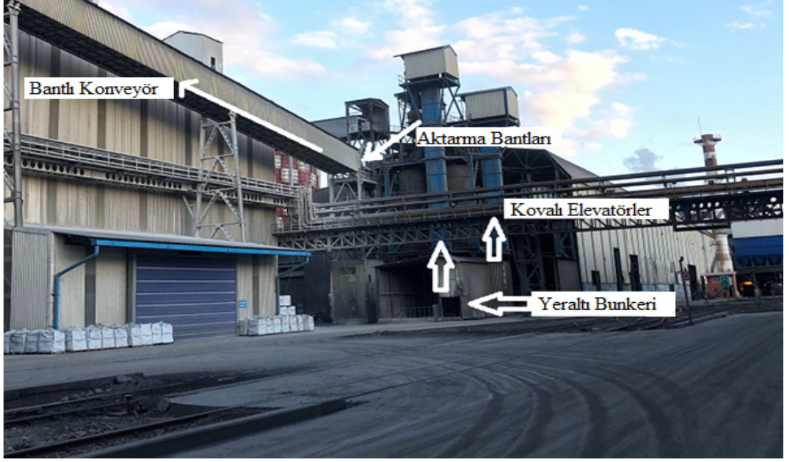
Şekil 4.2. Kardemir A.Ş. BOF katkı malzemelerinin çelik üretim tesisi içerisine nakil güzergahı görüntüsü.
