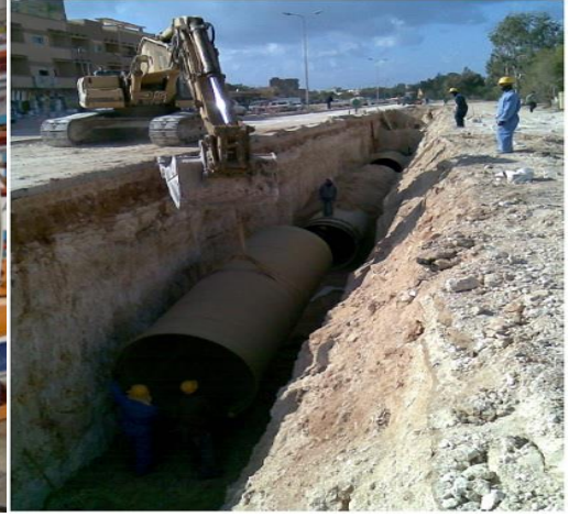
b) CTP boru döşenmesi
