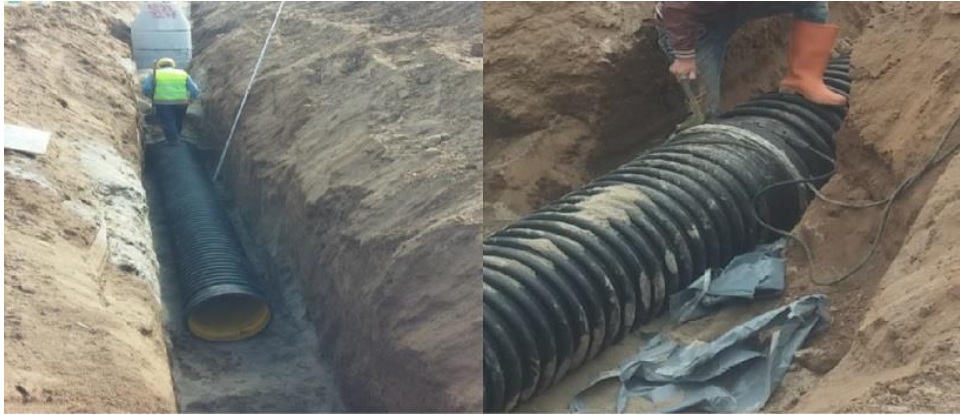
Şekil 2.5. Spiral sarımlı koruge borunun hendeğe yerleştirilmesi ve döşenmesi [3].
