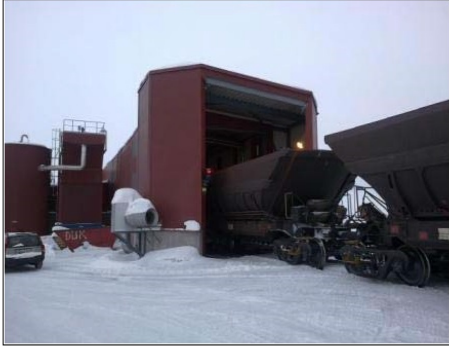
Şekil 2.1. Kiruna bölgesindeki vagon ısıtma holü.
