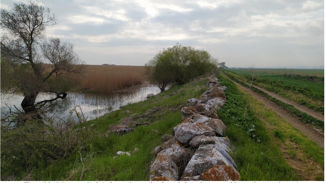
Foto 90: Manyas Gölü'nde seviye yükselmesini sağlayan sedde (göl güneybatısı)
