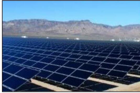
a) Sabit PV panel sistemi
