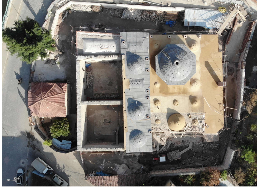
Şekil 3.38. Sultan Hamamı restorasyonu esnasında.
