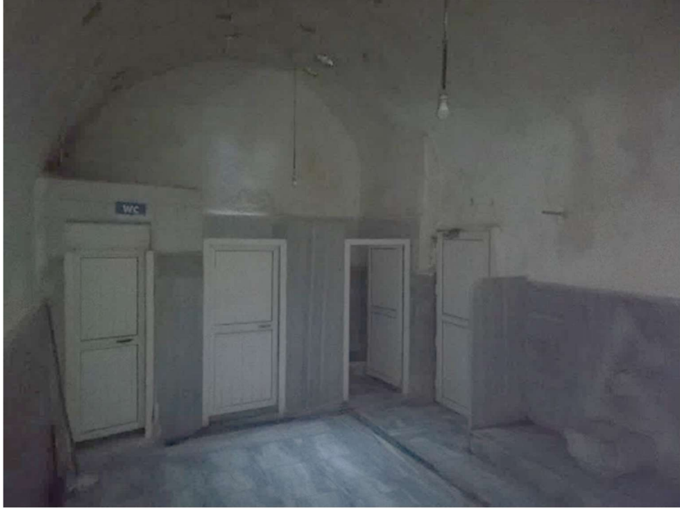
Şekil 3.83. Mevlâna Hamamı ılıklik kısmında tıraşlık ve hela bölümü.
