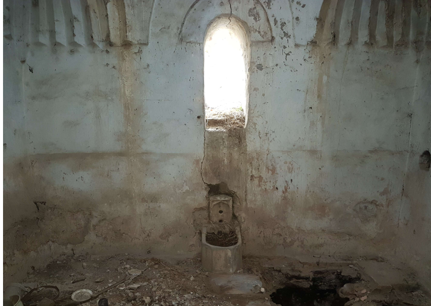
Şekil 3.8. Hatip Hamamı sıcaklık kısmında yer alan özgün kurna ve ayna taşı.
