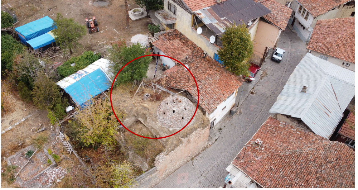
Şekil 3.115. Hatip Hamamı yapı çevre ilişkisi.
