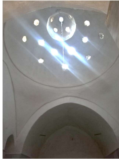
Şekil 3.84. Sıcaklık kısmının kubbeye geçiş elemanları ve kubbesi.
