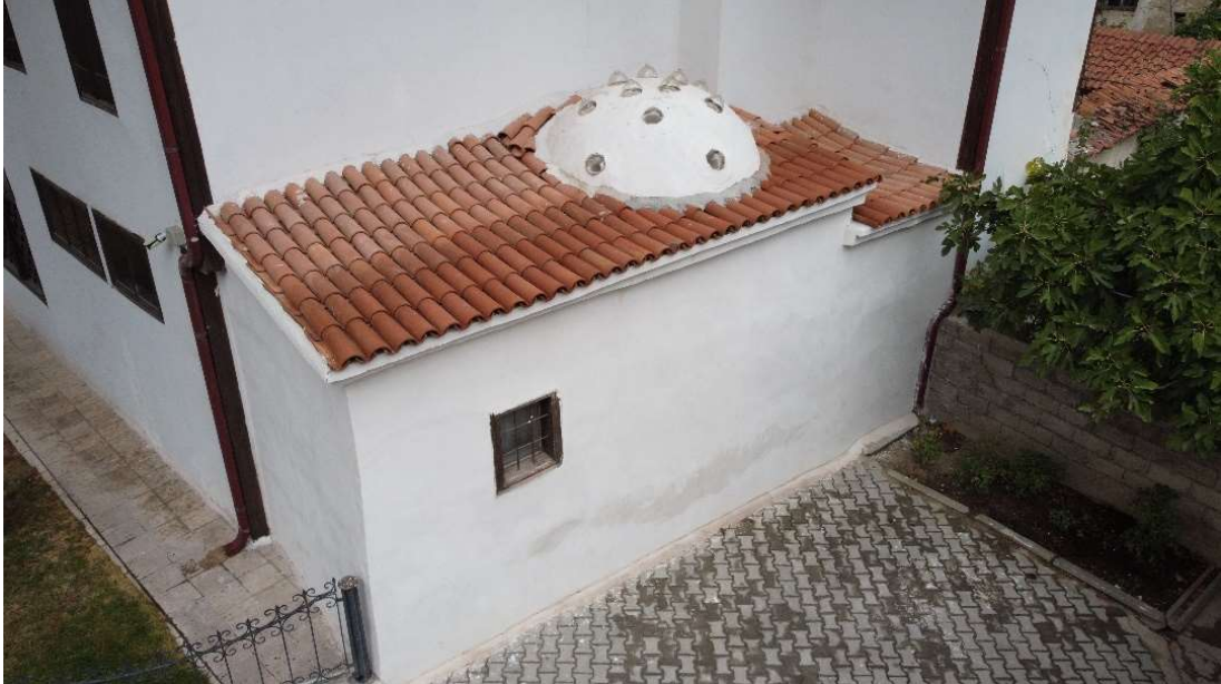
Şekil 3.136. Latifoğlu Konağı Hamamı dış görünüşü.
