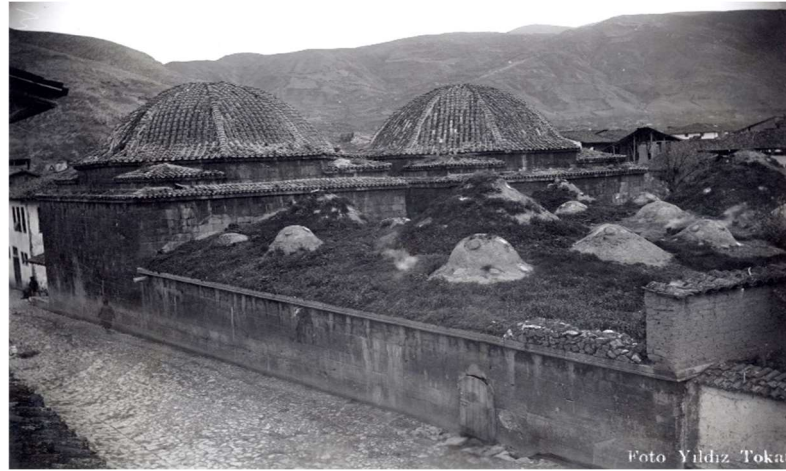
Şekil 3.45. Ali Paşa Hamamı kubbeleri kurşun ile kaplanmadan önce [27].
