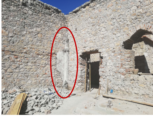
a) Sultan Hamamına eklenmiş bir kolon örneği
