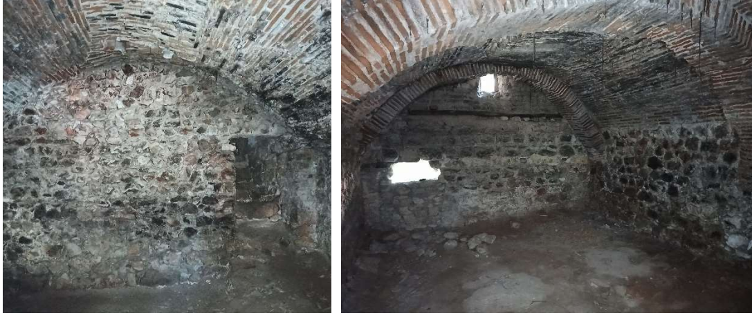
a) Üstte yer alan mekâna ıkan merdiven
