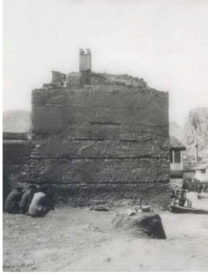
a) Marisa Hamamı batı cephesi
