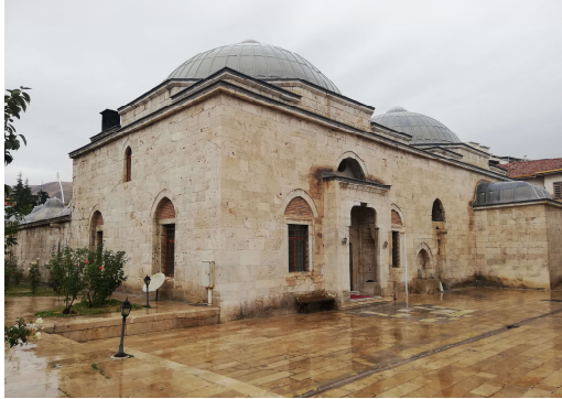
a) Ali Paşa Hamamı avludan görünüşü
