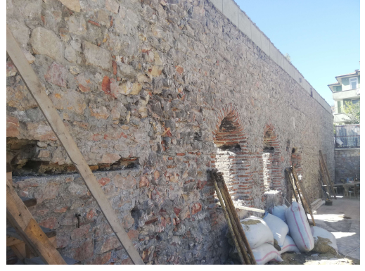
d) Sultan Hamamı soyunmalık kısmı cephesi
