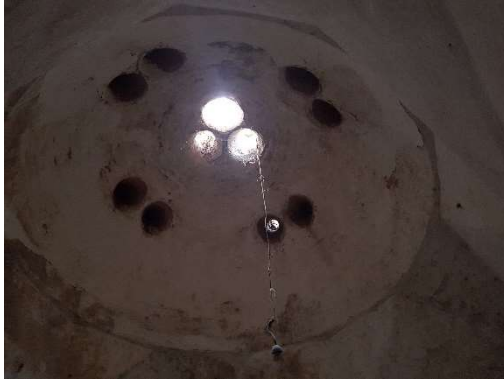
a) Sıcaklık kısmındaki halvet kubbesi
