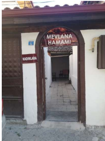
a) Giriş kapısı
