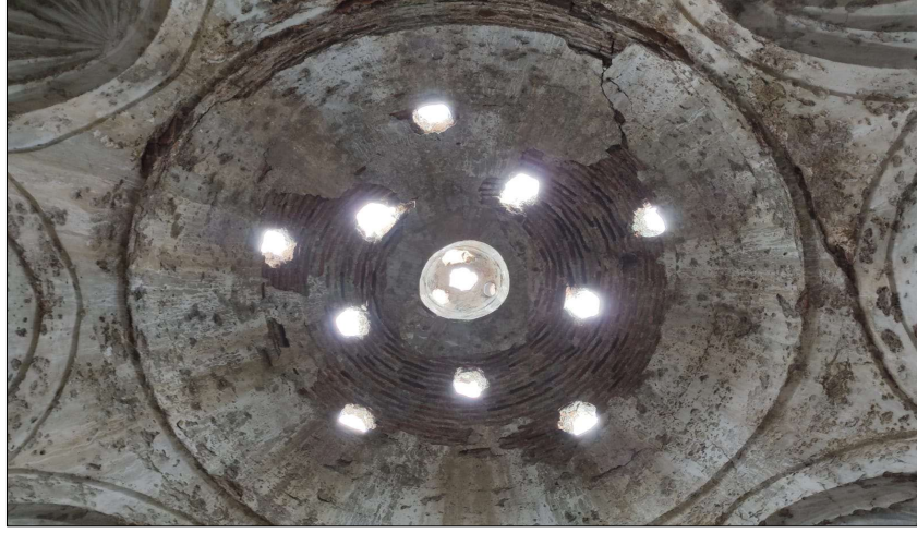
Şekil 3.121. Hatip Hamamı sıcaklık kısmı kubbesi.
