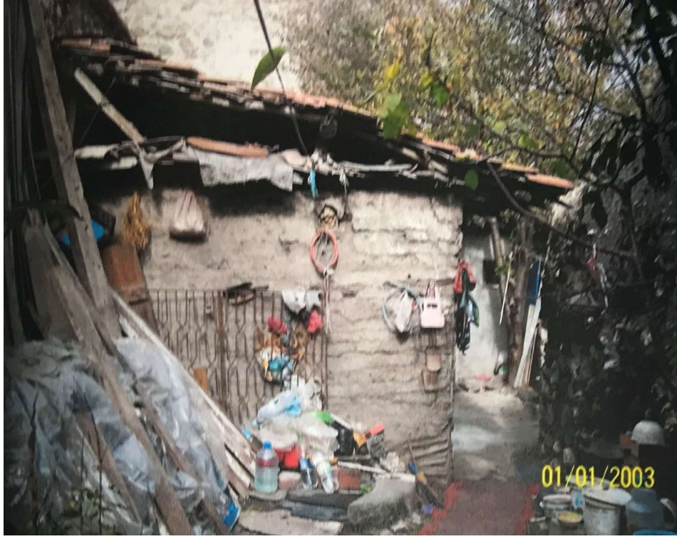
Şekil 3.68. Paşa Hamamı hamamcı evi [26] .
