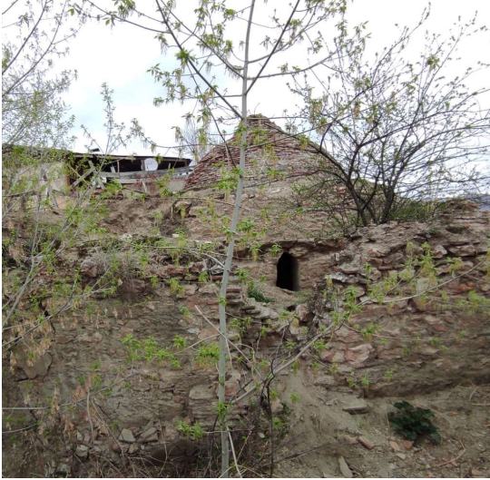
a) Hatip Hamamı giriş cephesi
