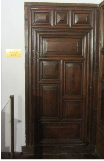
a) Giriş kapısı
