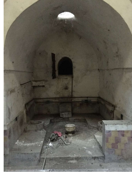
b) Sıcaklık kısmında eyvan
