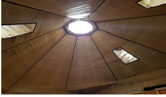
a) Soyunmalık kısmı ahşap çatısı
