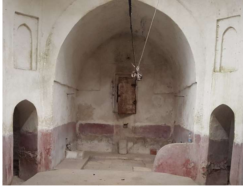
Şekil 3.9. Paşa Hamamı su deposu penceresi.
