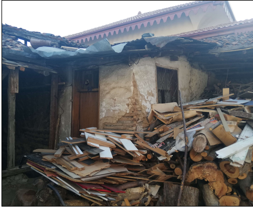
Şekil 3.12. Mevlâna Hamamı'nda yer alan külhancı evi.
