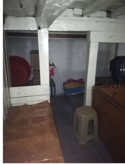
b) Merdiven Sağında Kalan Ara Kısım
