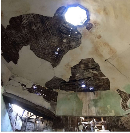
a) Soyunmalığın bağdadi kubbesi ve ışık feneri
