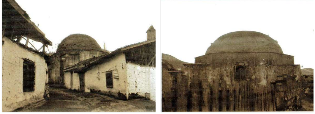
Şekil 3.104. Çay Hamamı cepheleri [6].
