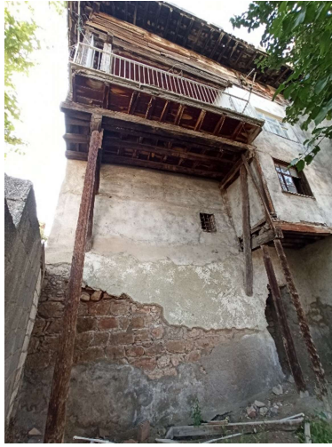
a) Yapı üzerinde yer alan konut
