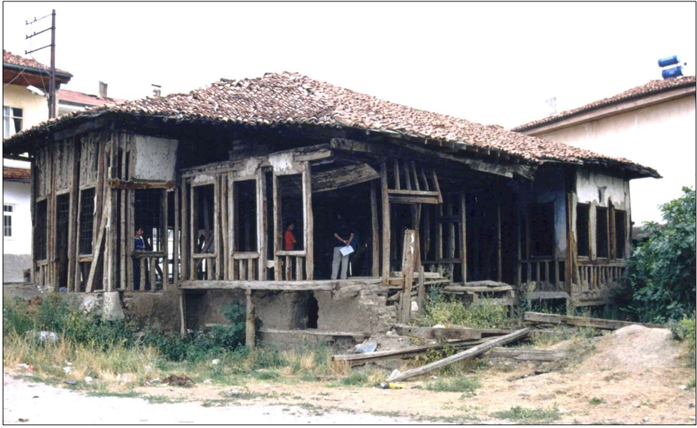
Şekil 3.154. Muslu Ağa Köşkü tespit çalışmaları yapılırken [37].
