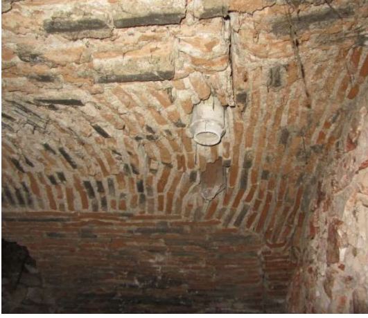
a) Tonozda bulunan pöhrenkler
