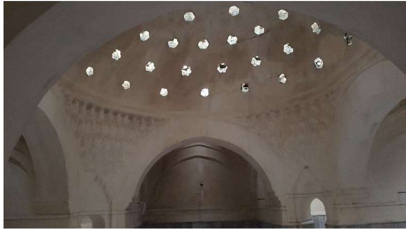
e) Sıcaklık kısmında kubbeye geçiş elemanları ve süslemeler
