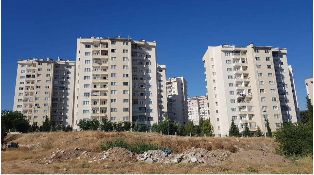
Şekil 4.48. Musalla Mahallesi TOKİ konutları.
