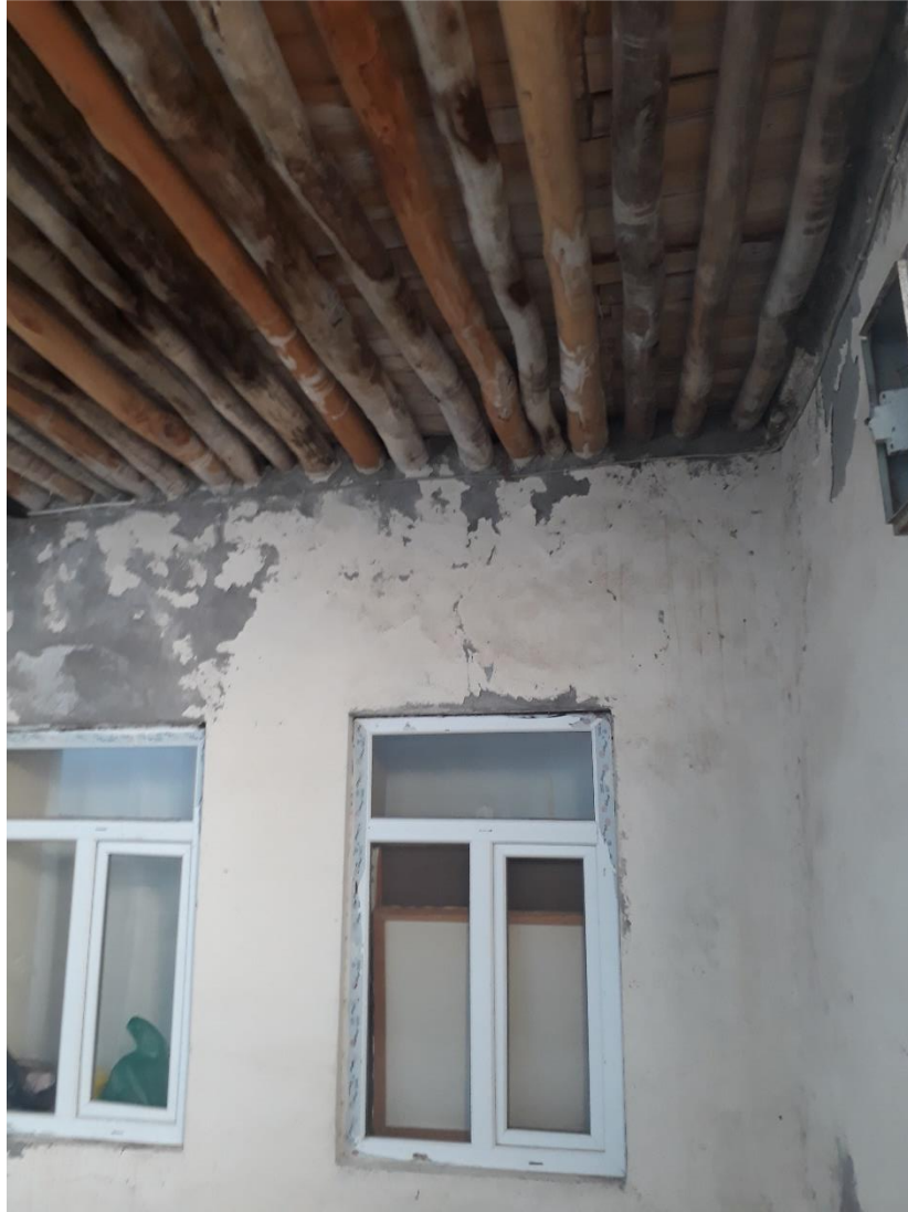
Şekil 2.4. Yapının özgünlüğünü bozan çimento esaslı sıva ve pencere örneği.
