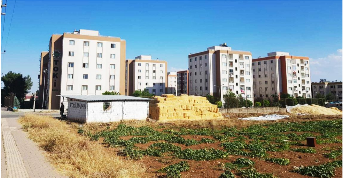
Şekil 4.50. Bahçecik Mahallesi TOKİ konutları.
