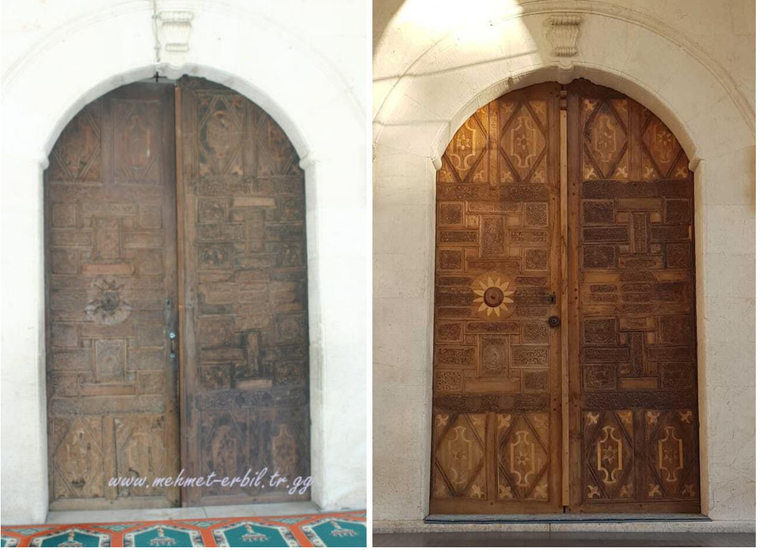
Şekil 4.27. Adiyaman Ulu Camii kuzey kapısı restorasyon öncesi ve sonrası.
