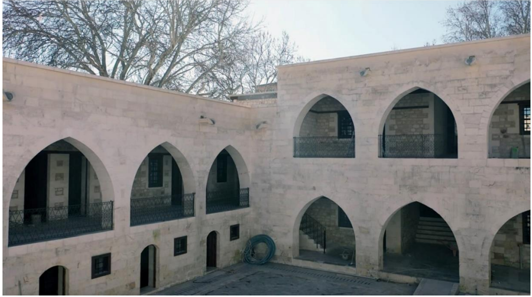
Şekil 5.7. Tuz Hanı restorasyon öncesi (Erbil'in arşivi) ve sonrası.
