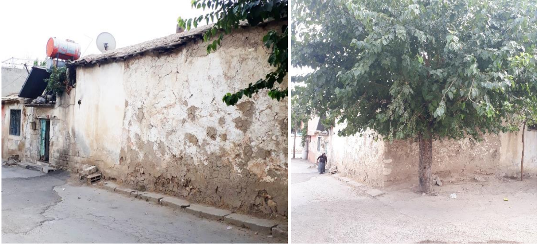
Şekil 5.38. Mara Mahallesi'nde sokak çeperi oluşturan Bakır Evi dış duvarları.
