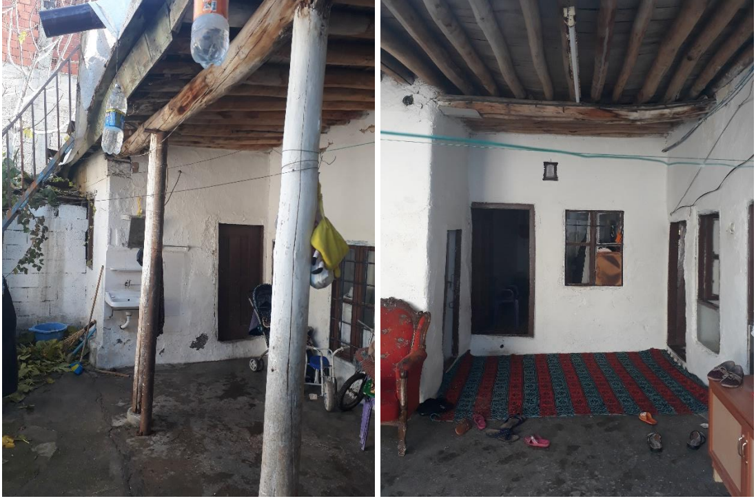
Şekil 5.39. Musalla Mahallesi'nde (518 ada, 16. parselde) yer alan bir geleneksel konutta hayat mekânı.
