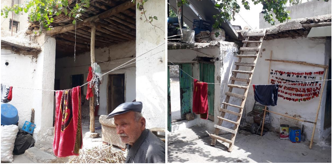
Şekil 5.32. Mara Mahallesi'nde yer alan Bakır Evi solda revak (portik) kısmını ayakta tutan ahşap sütun, sağda avlunun bir kısmı.
