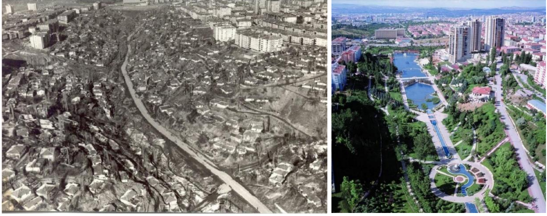
Şekil 4.35. Dikmen Vadisi, 1989 yılı ve kentsel dönüşüm sonrası durumu (Bal, 2017).
