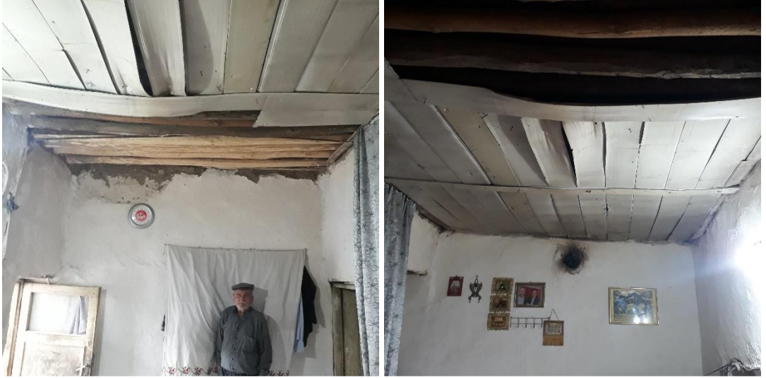
Şekil 5.35. Mara Mahallesi'nde yer alan Bakır Evi baş odası.
