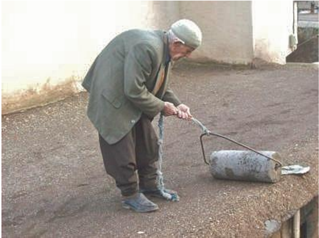
Şekil 5.19. Adıyaman'da toprak damda loğlama yapımı (Adıyaman Belediyesi arşivi).
