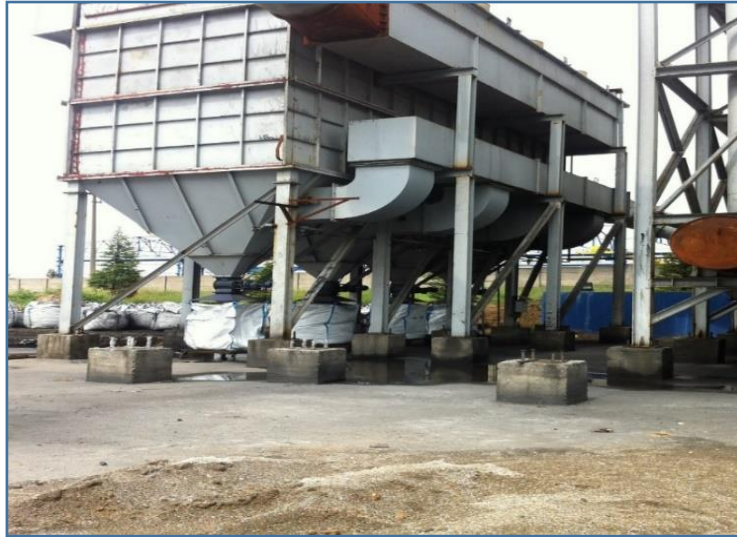
Şekil 4.11. Toz tutma tesisinin genel görünüşü
