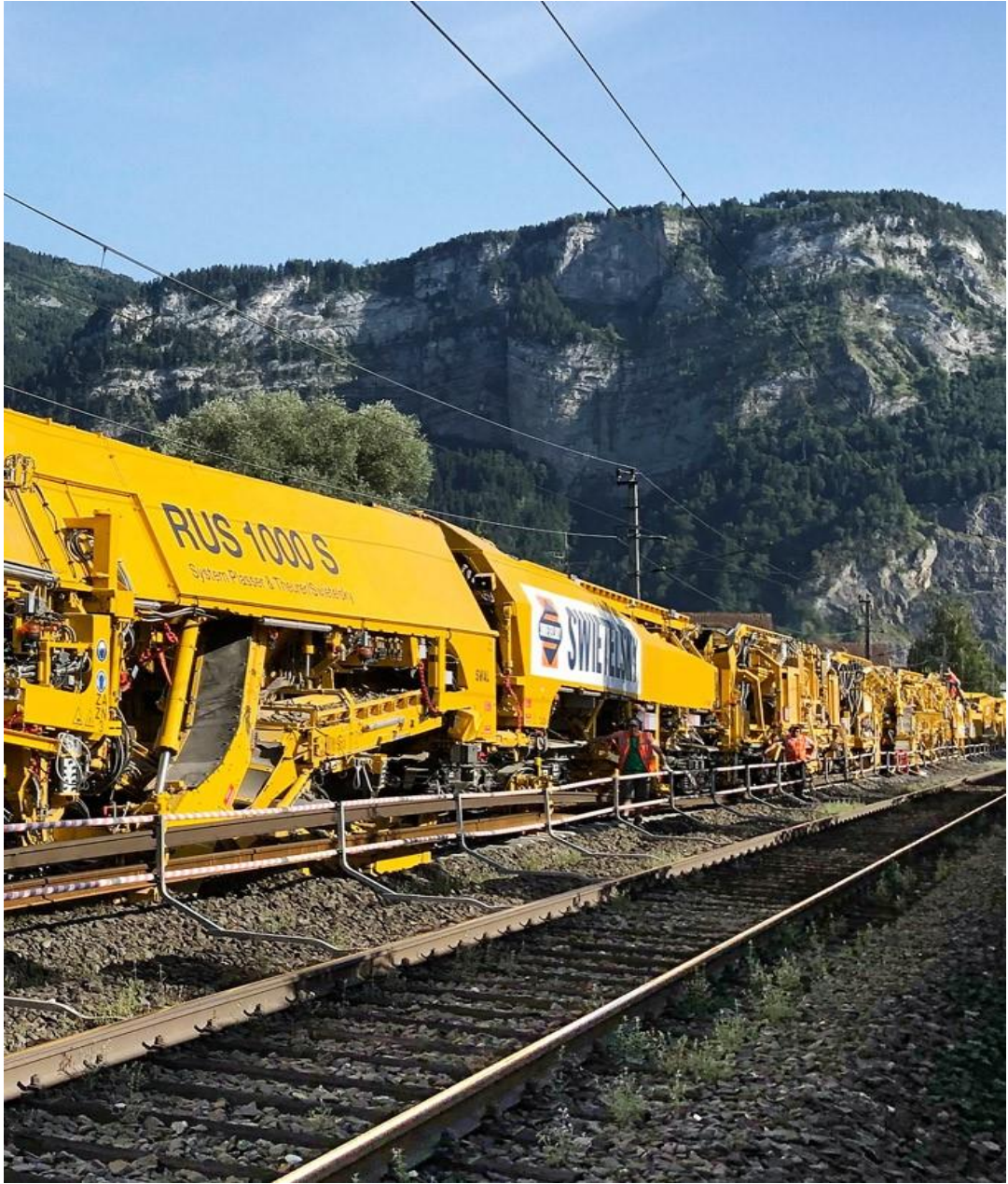
Şekil 2.5. Makinelerle travers ve rayların döşenmesi [4].
