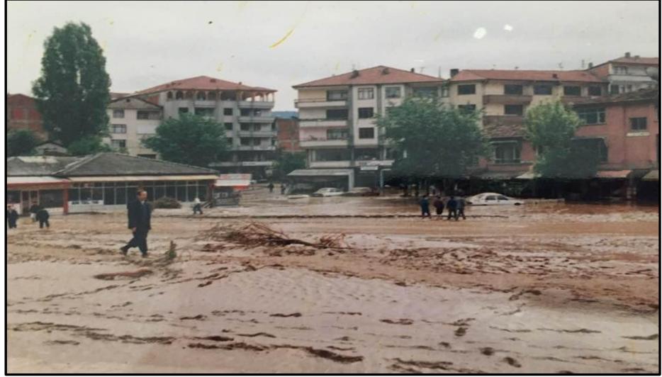
Fotoğraf 100. 21 Mayıs 1998 tarihinde Devrek'te meydana gelen taşkında çok sayıda ev ve işyeri sular altında kalmış, ilçe genelinde büyük hasar oluşmuştur (url-9).
