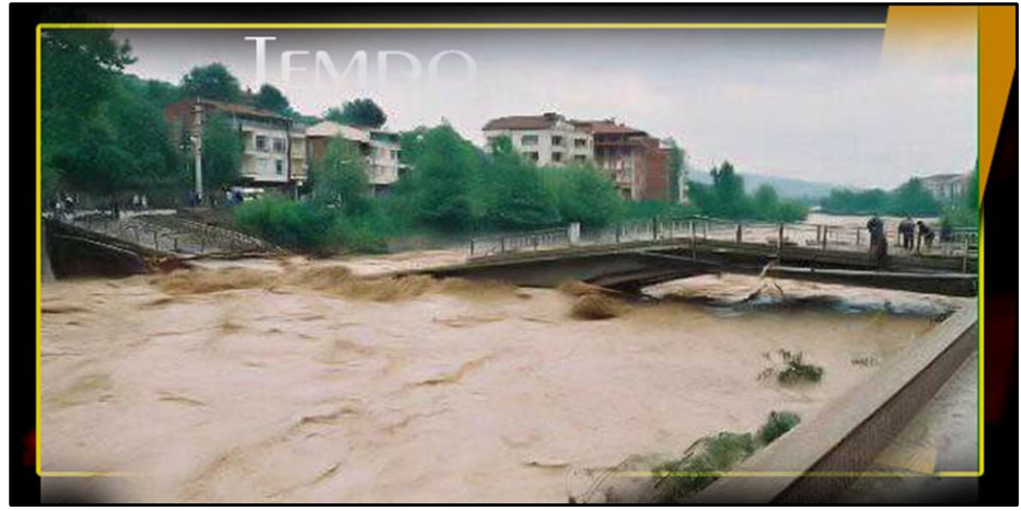
Fotoğraf 101. 21 Mayıs 1998 tarihinde Devrek'te meydana gelen taşkın, köprülerde hasara yol açmıştır (url-10)
