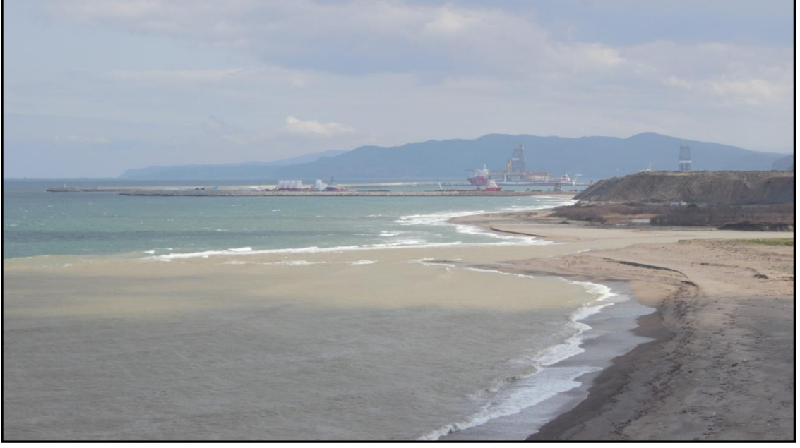
Fotoğraf 90. Filyos Limanı İnşaatından Bir Görünüm.
