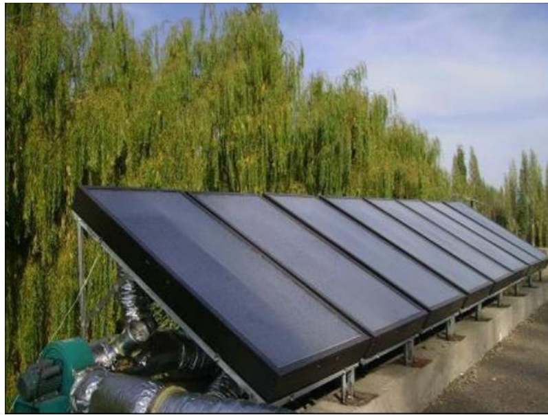
Şekil 2.7. Tipik havalı kolektörler [26].
