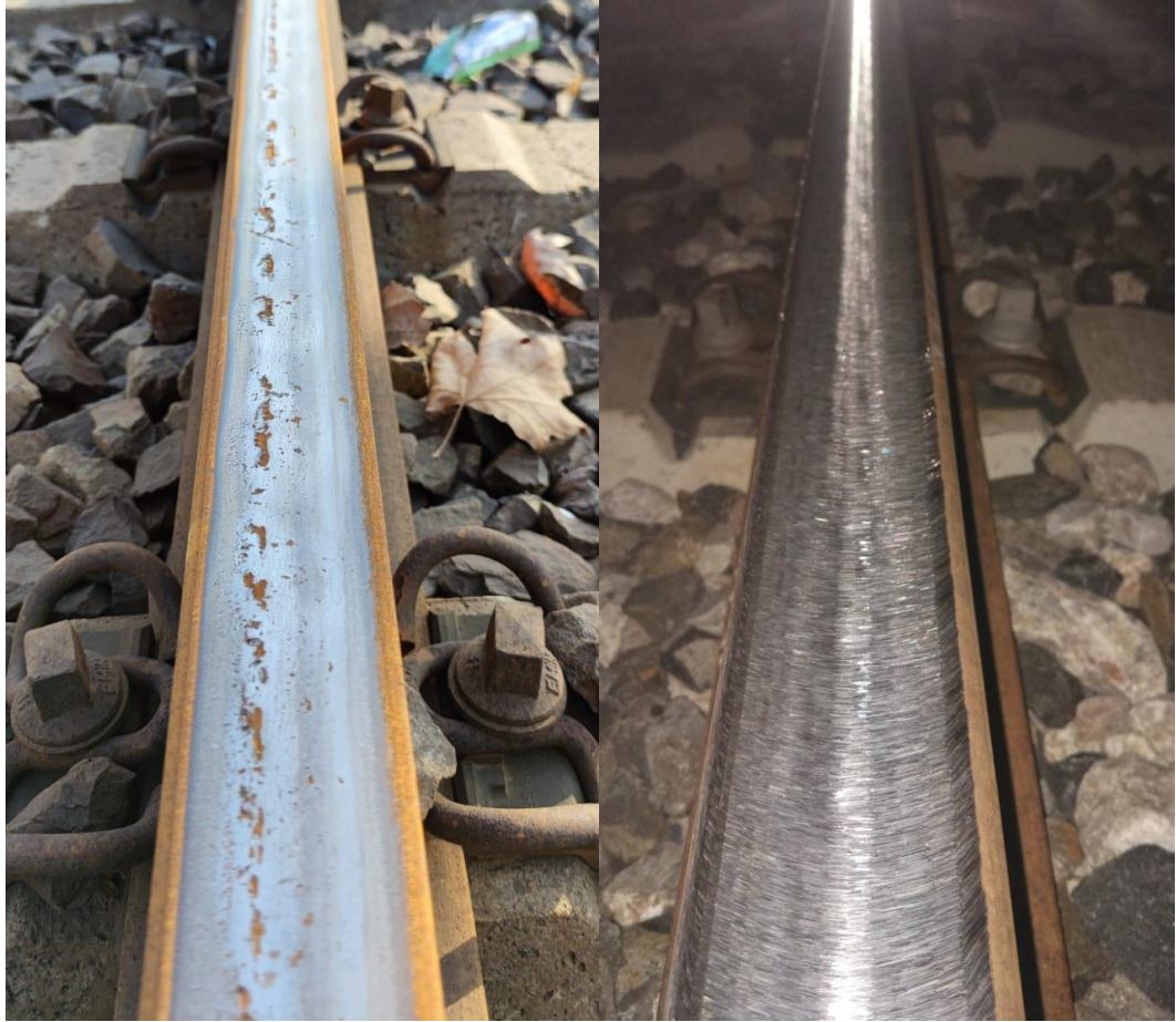
Şekil 6.3. Örnek taşlama öncesi ve sonrası ray yüzeyi.
