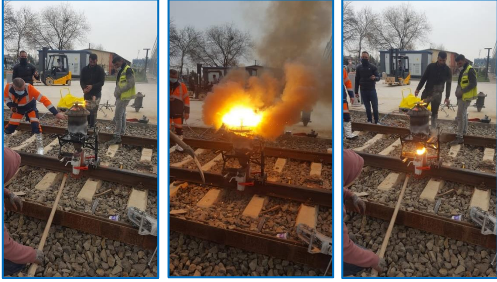
Şekil 4.5. Alüminotermite kaynağı başlama anı.
