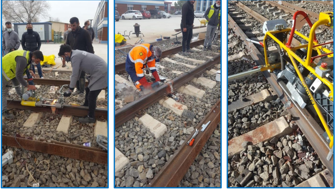
Şekil 4.6. Alüminotermite kaynak bölgesinin fazlalıklardan temizlenmesi.
