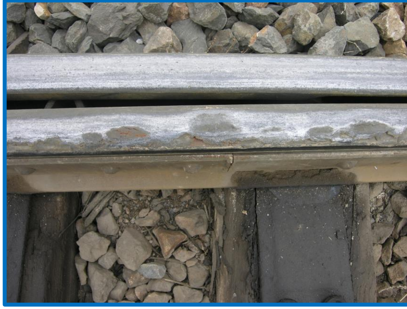
Şekil 2.26. Ray mantarında görülen Ezilme (squat) [21].
