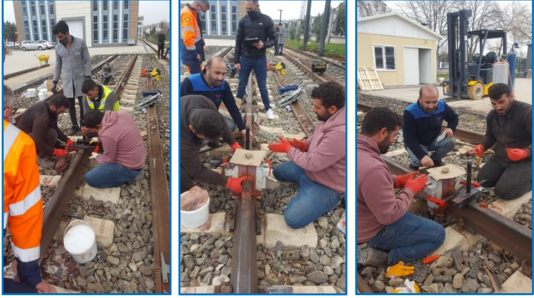
Şekil 4.4. Termit kaynağından önce mastarlama ve kalıpların yerleştirilmesi.
