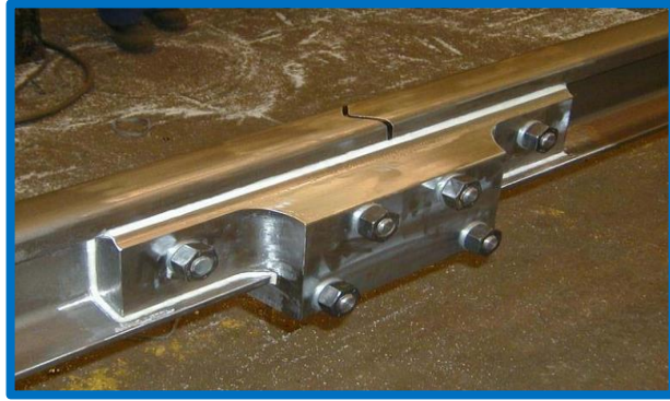
Şekil 2.16. İzoleli Cebire ve bulonlarla rayların birleştirilmesi [31].
