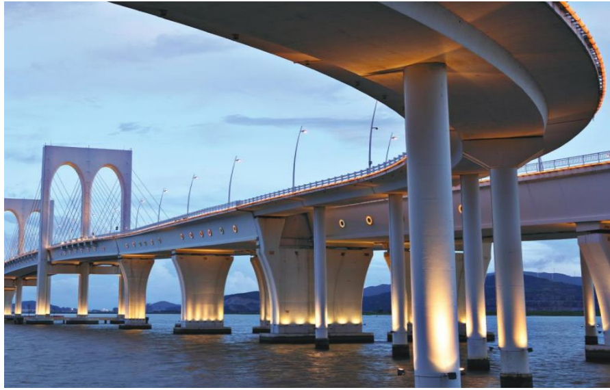
Şekil 1.3. CTP profillerle üretilmiş hafif yapı [8].
