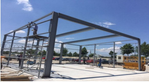
Şekil 1. U profillerin çelik yapılarda kullanımı [1,2]
