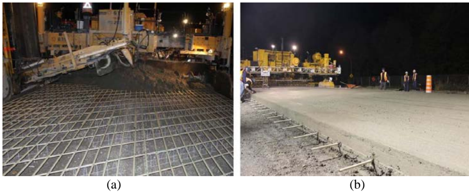
Şekil 3. GFRP donatılı beton yol uygulaması: beton döküm aşaması (a), döküm sonrası (b) [6]
