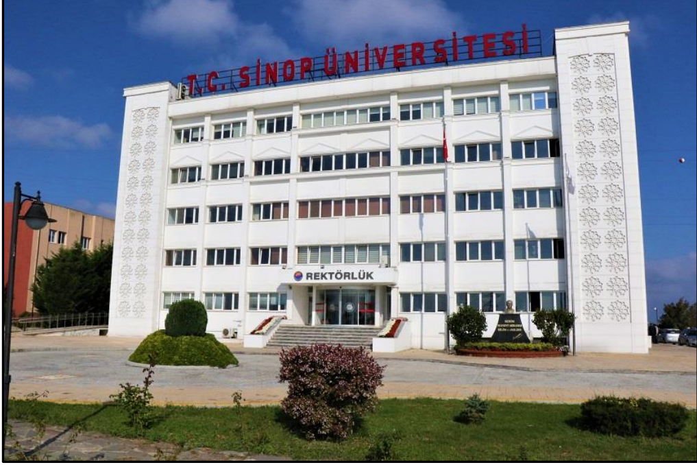
Fotoğraf 13: Sinop Üniversitesi Rektörlük Binasından Bir Görünüm
