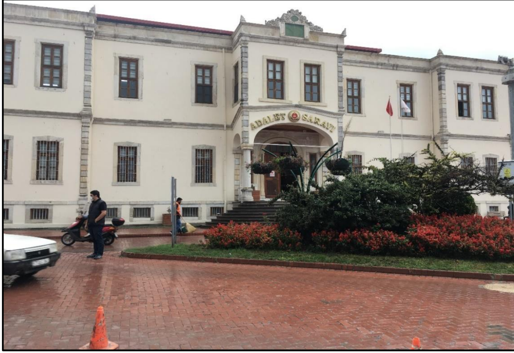
Fotoğraf 5: Günümüzde Adliye Sarayı Olarak Kullanılan Eski Hükümet Binası
