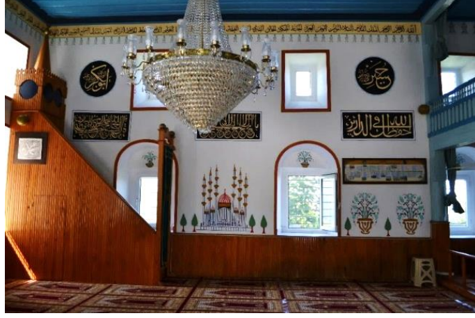
Foto. 130: Petekli Köyü Mehmet Çebi Cami-Batı Duvarı
