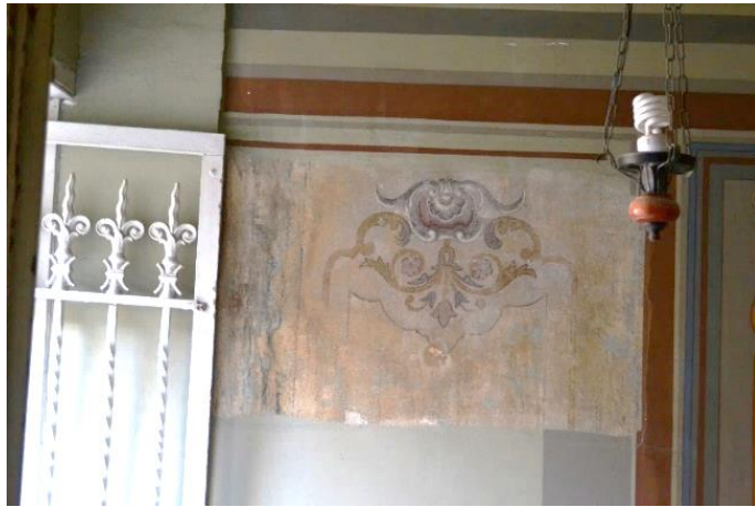
Foto. 87: Kostaki Konağı, 2. Kat Koridor
