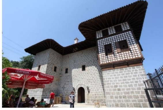
Foto. 118: Memiş Ağa Konağı (Trabzon Kültür Varlıkları ve Müzeler Genel Müdürlüğü)
