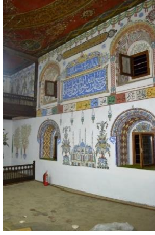
Foto. 240: Kabataş Köyü Merkez Cami-Doğu Duvarı
