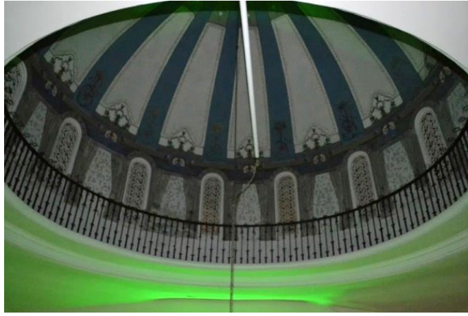
Foto. 101: Hacı Kasım Cami-Kubbe
