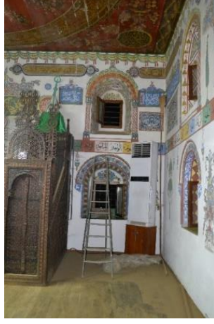
Foto. 236: Kabataş Köyü Merkez Cami-Güney Duvarı
