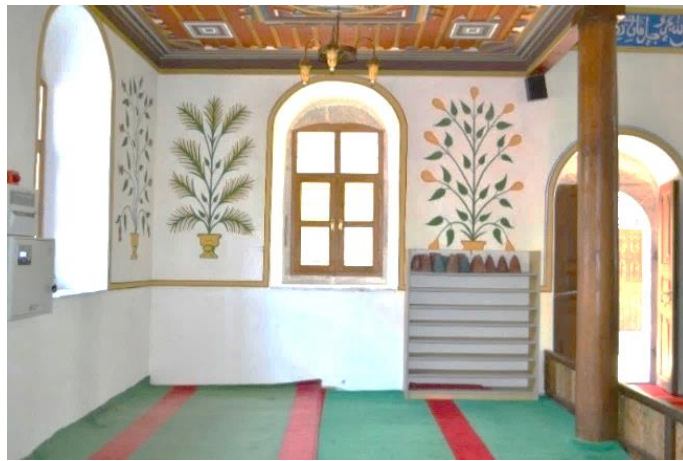
Foto. 210: Atayurt-Çatak Mahallesi Cami-Doğu Duvarı
