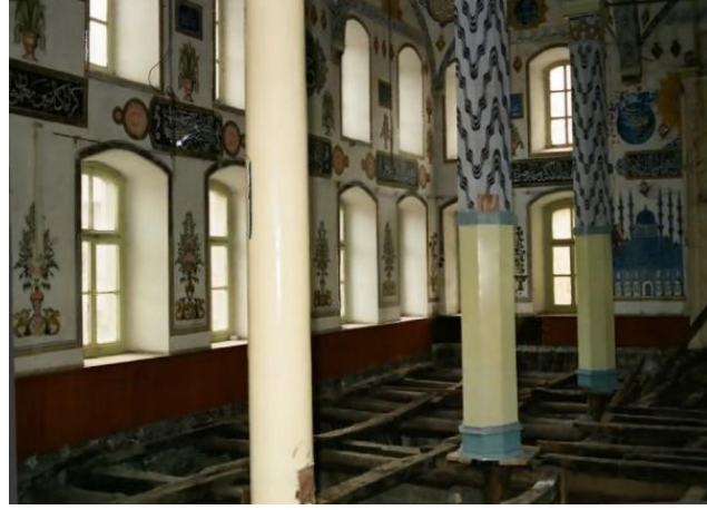
Foto. 283: Araklı Merkez Cami Doğu Duvar (Şahin, 2016, s. 87)
