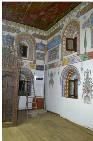
Foto. 235: Kabataş Köyü Merkez Cami-Batı Duvarı
