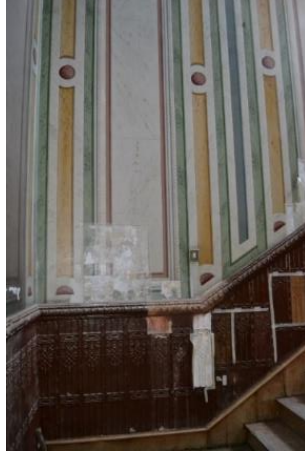
Foto. 46: Kostaki Konađı, Zemin kat 16 nolu alan-Merdiven
