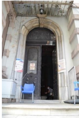
Foto. 21: Kostaki Konađı, Zemin kat 01 nolu alan-Giriř Kapı Ve Gvenlik Blm
