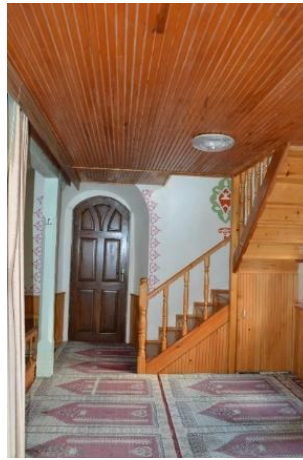
Foto. 173: Aşağı Ovalı Mahalle Cami- Batı Duvarı
