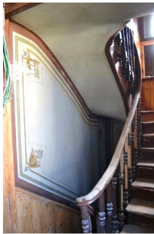
Foto. 78: Kostaki Konađı, 2. Kat 01 nolu alan -Merdiven
