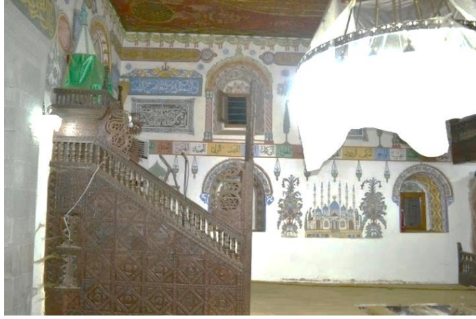
Foto. 234: Kabataş Köyü Merkez Cami-Batı Duvarı
