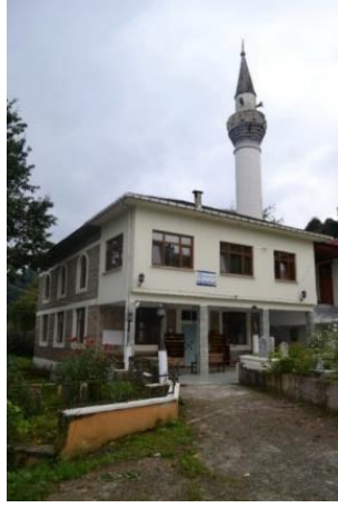
Foto. 347: Balaban Mahallesi Cami
