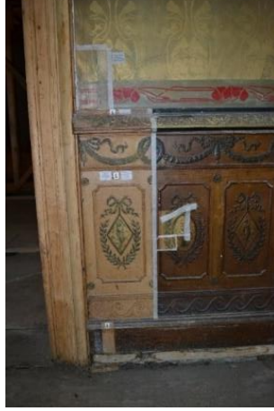
Foto. 47: Kostaki Konađı, Zemin kat 16 nolu alan-Merdiven
