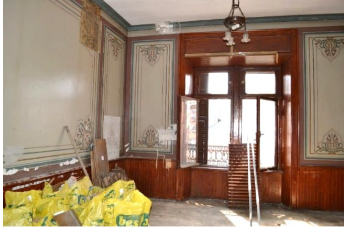
Foto. 85: Kostaki Konağı, 2. Kat 17 nolu oda -Memur Odası
