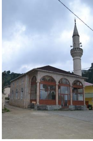
Foto. 314: Bahçekaya Merkez Cami
