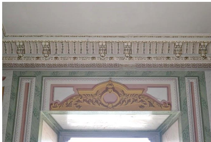
Foto. 48: Kostaki Konađı, Zemin kat 16 nolu alan-Merdiven
