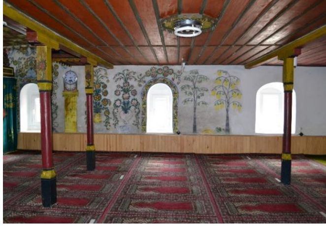
Foto. 381: Doğancı Mahalle Merkez Cami-Batı Duvarı
