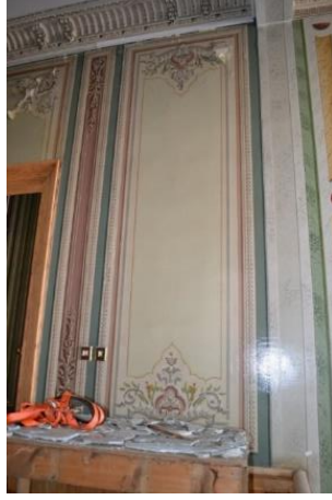
Foto. 49: Kostaki Konađı, 1. Kat 01 nolu alan Merdiven Hol
