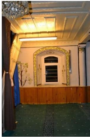
Foto. 338: Sayraç Köyü Cami-Doğu Duvarı
