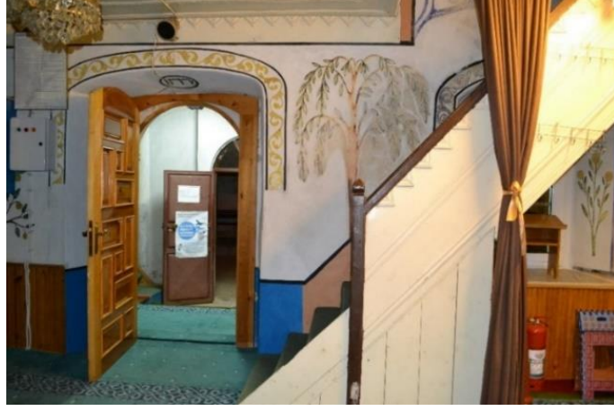
Foto. 339: Sayraç Köyü Cami-Kuzey Duvarı
