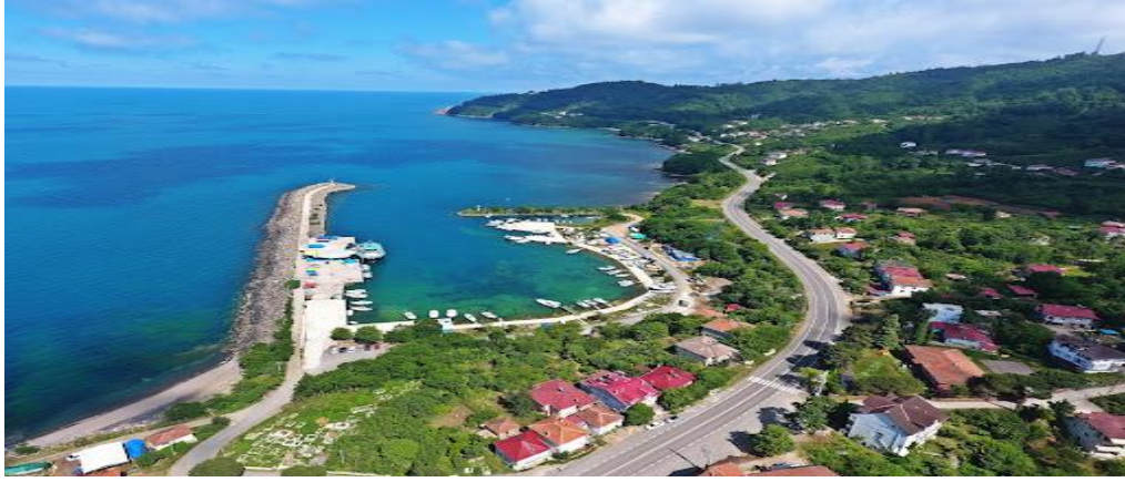
Resim 28: Mersin Köyü Balıkçı Barınağı
