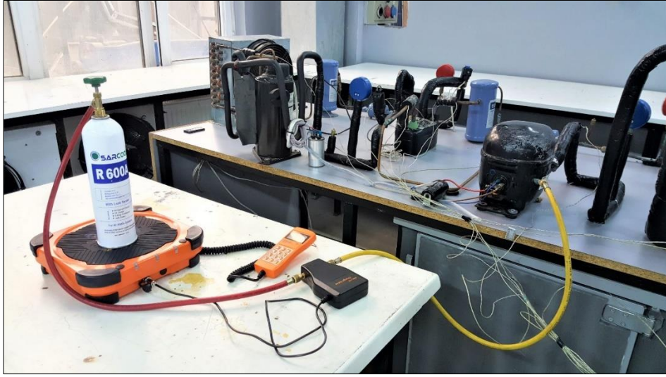
Şekil 5.15. R600a soğutucu akışkan şarjı uygulaması.
