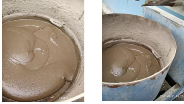
Şekil 6.3. Gaz beton homojen karışımı.
