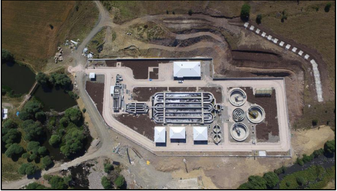
Fotoğraf 118. Gerede Modern Biyolojik Arıtma Tesisinden bir görünüm Kaynak: Gerede Belediyesi
