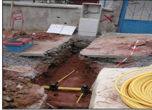
Şekil 4.2. S 700 Duvar tipi servis kutusu [8].
