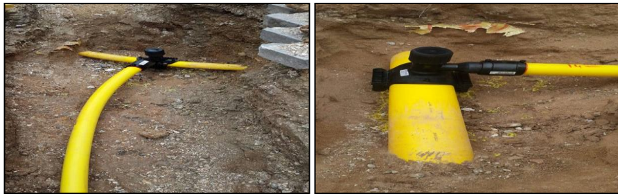
Şekil 4.6. Farklı çaplarda dağıtım hattı kaynakları
