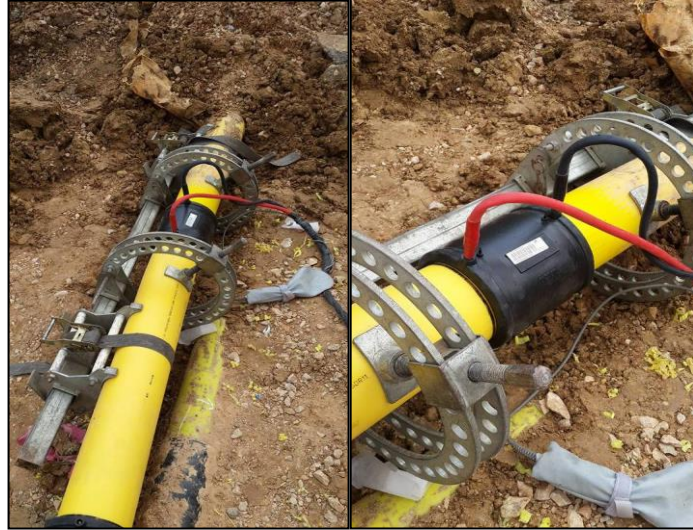
Şekil 4.8. Manşon kaynağı
