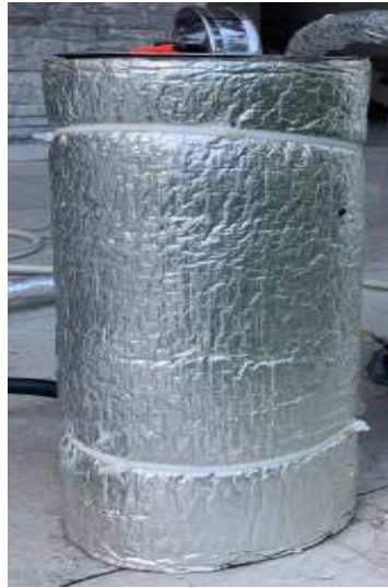
Şekil 5.7. Isı transfer akışkanı deposu.
