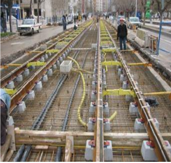
Şekil 21. Betonlu Üstyapı yapılırken.
