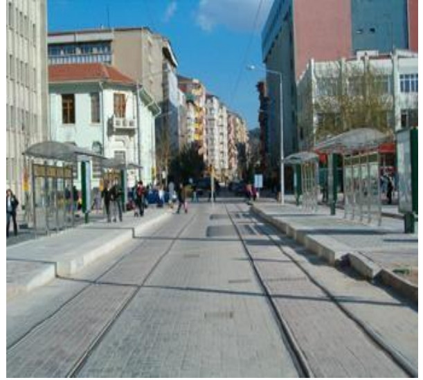
Şekil 22. Betonlu Üstyapı bitmiş hali.
