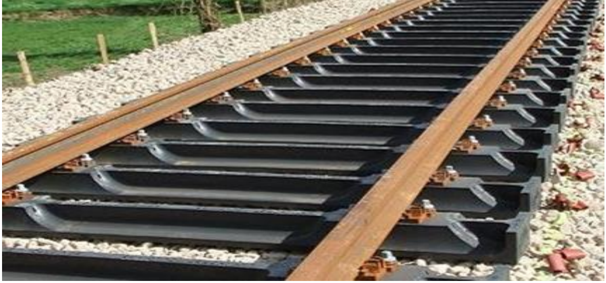
Şekil 28. Plastik (Poliüretan) Travers.
