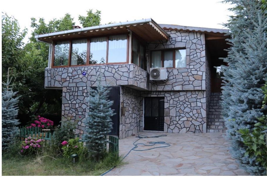
Fotoğraf 84. Ekoköy Sahiplerinin Konakladığı, Taş ve Ahşap Yapı Malzemeler Kullanılarak İnşa Edilen Konut
