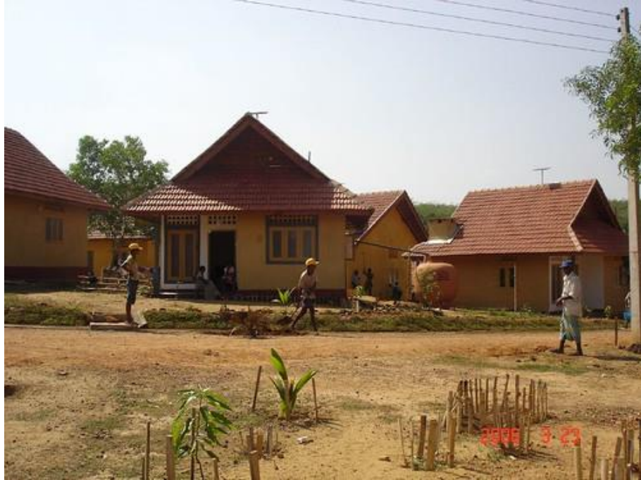
Fotoğraf 5. Sarvodaya Ekoköyü'nde İnşa Çalışmaları-2 (URL-11)
