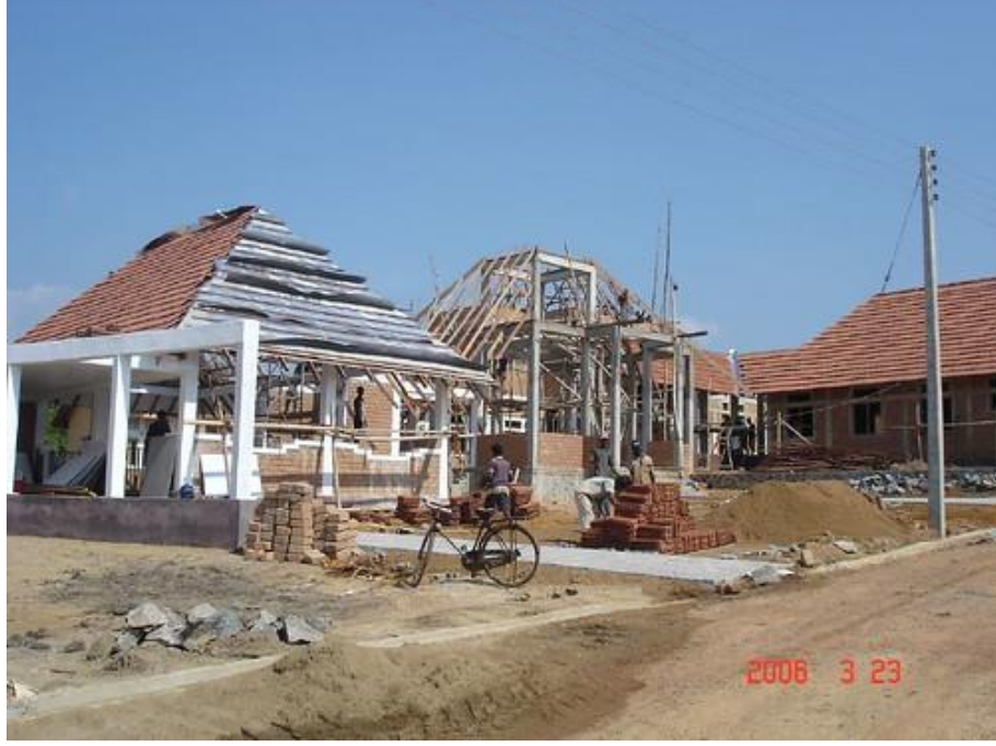
Fotoğraf 4. Sarvodaya Ekoköyü'nde İnşa Çalışmaları-1 (URL-11)
