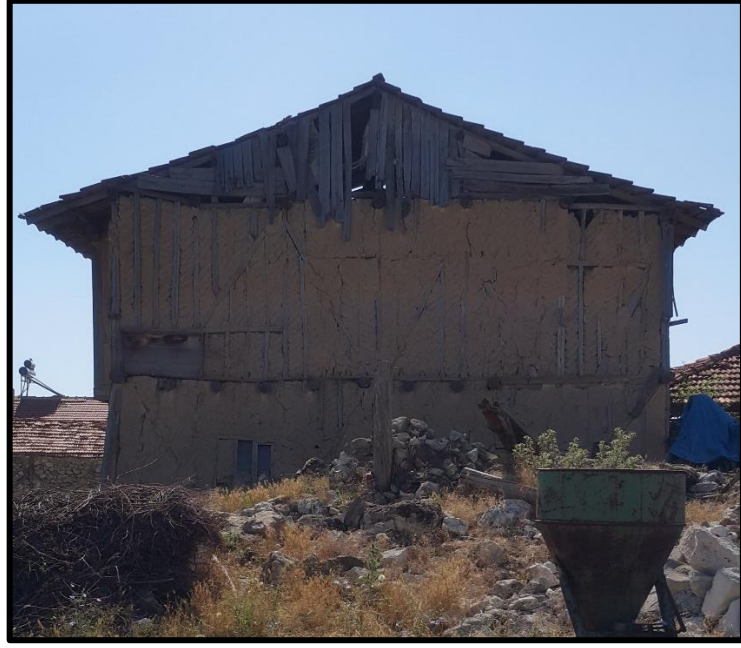
Fotoğraf 85: Porsuk Çayı Havzası'nda kırsal yerleşmelerde meskenlerin iskeleti ahşap malzemedен yapılarak arası kerpiçle doldurulmuştur (Kütahya Ağaçköy).
