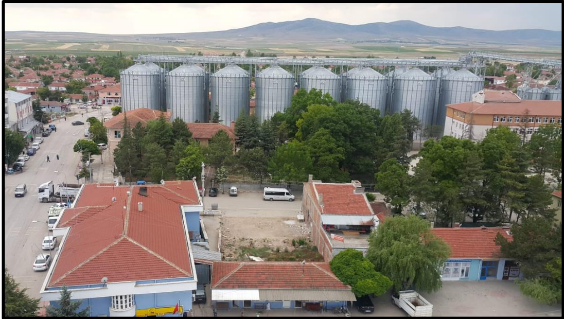
Fotoğraf 92: Havzada en çok mısır üretim alanının olduğu Alpu'da mısırlar, silolarda depolanmaktadır (Fotoğraf Alpu Merkez Camiinin minaresinden çekilmiştir).
