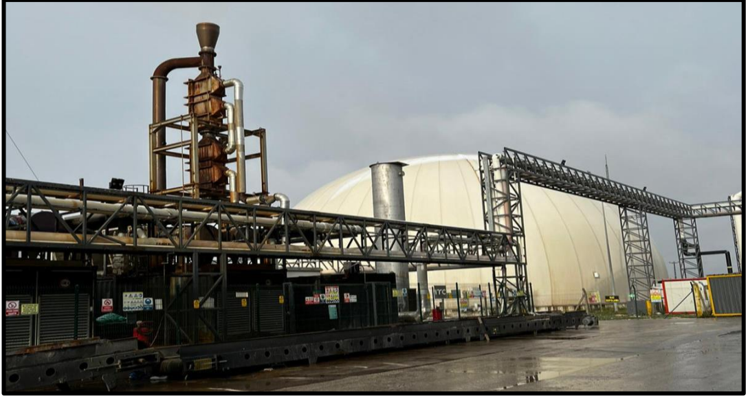
Fotoğraf 117: ES ES Eskişehir Enerji Sanayi ve Ticaret A.Ş. Kojenerasyon Ünitesi'nde biyogazla elde edilen enerji fotoğrafın geri planındaki büyük kürede toplanmaktadır.
