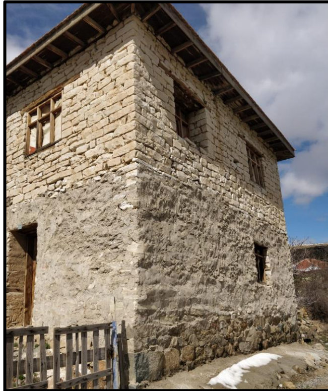
Fotoğraf 86: Yakın çevreden sağlanan malzemelerle oluşturulmuş geleneksel bir taş-kerpiç karışımı mesken (Polatlı Gençali Mahallesi).
