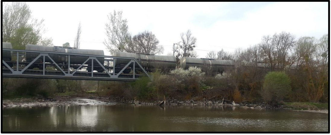
Fotoğraf 122: Eskişehir-Kütahya arasındaki demiryolu güzergahı Porsuk Çayı üzerinde köprülerle devam etmektedir (Fotoğraf Eskişehir Yenisoğça köyü yakınlarında çekilmiştir).
