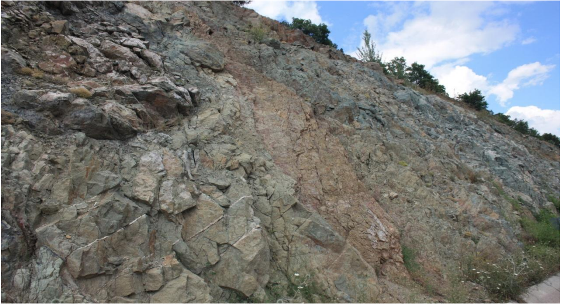
Foto 2: Ilgaz-Tosya yolu boyunca görülen andezitler, üzerinde sığ toprak ve seyrek bitki örtüsü. Bu durum, yüzeysel akımı artırıcı rol oynamaktadır.
