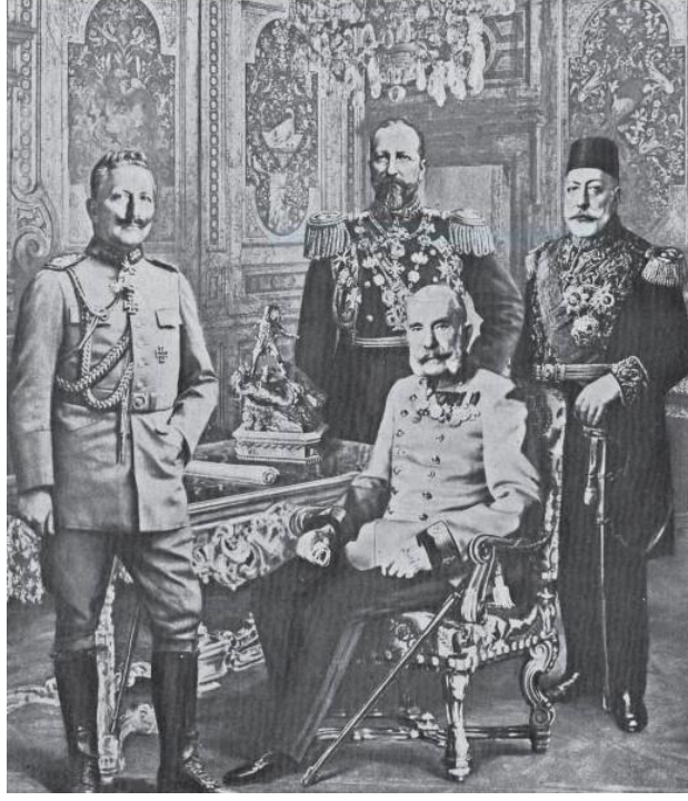
Fotoğraf 15: Üçlü İttifak, Anonim, t.y., Fotoğraf, (Gurulkan, Kırca, Genç, ve vd., 2013, s.39).
