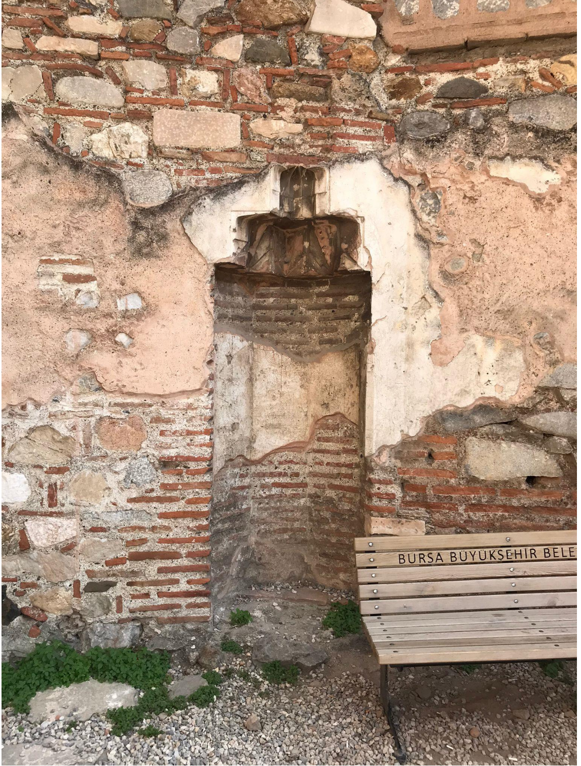
Fotoğraf 129. Güney narteks duvarında bulunan mihrap nişi (Eylül 2021)
