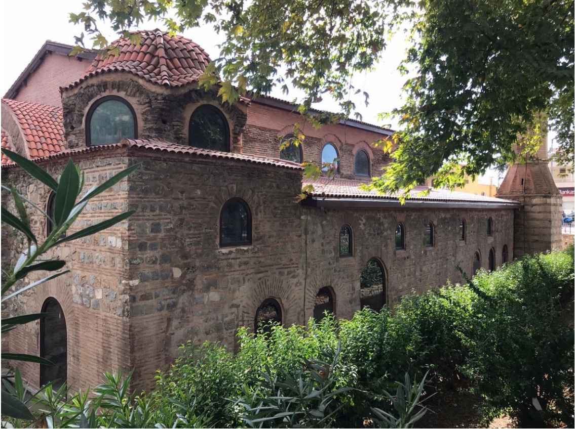
Fotoğraf 118. İznik Ayasofyası kuzey cephe görünümü (Eylül 2021)
