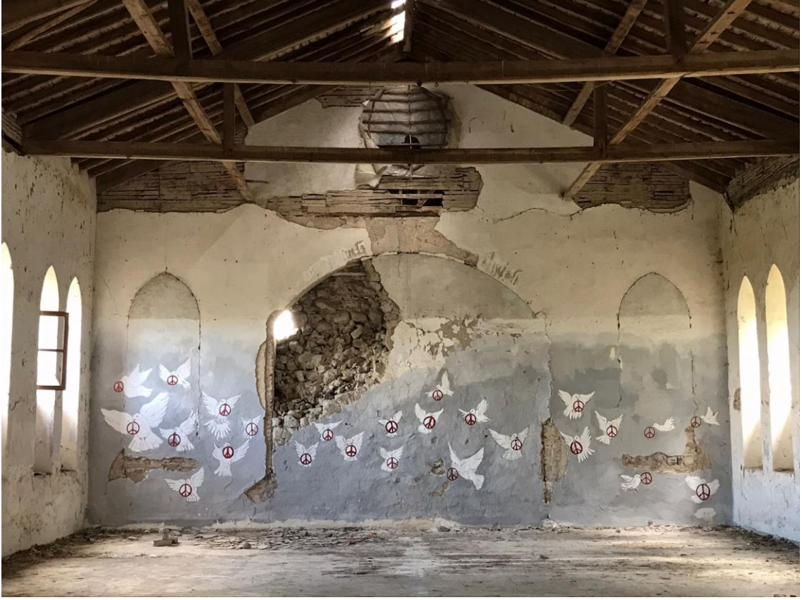
Fotoğraf 75. Birinci kat kuzeydoğu duvarına bakış (Eylül 2021)
