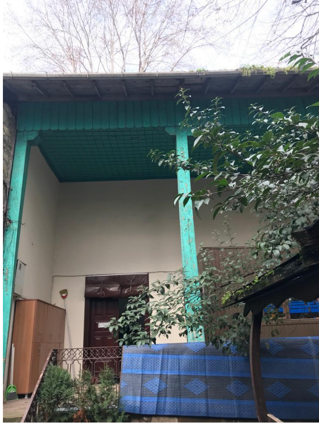
Fotoğraf 58. Sıbyan mektebi güney cephe giriş bölümü (Eylül 2021)
