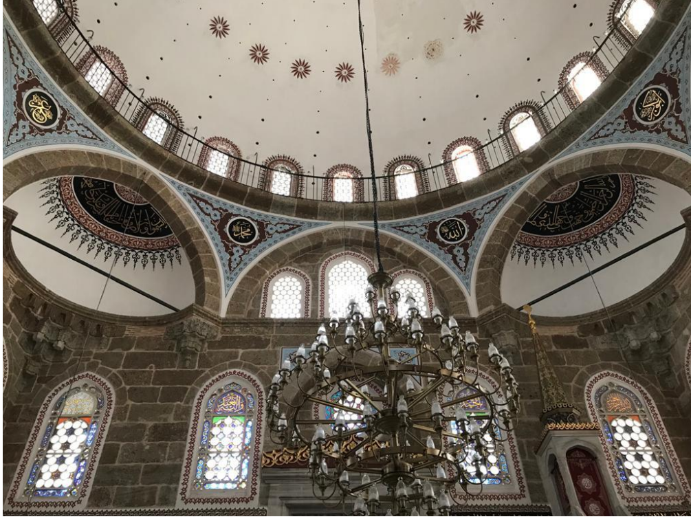
Fotoğraf 47. Kubbeye geçişi sağlayan tromp detayı (Eylül 2021)
