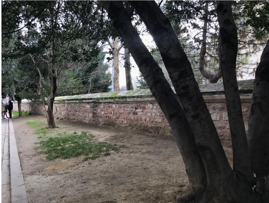
Fotoğraf 16. Doğu cephe arka avlu duvarı (Eylül 2021)
