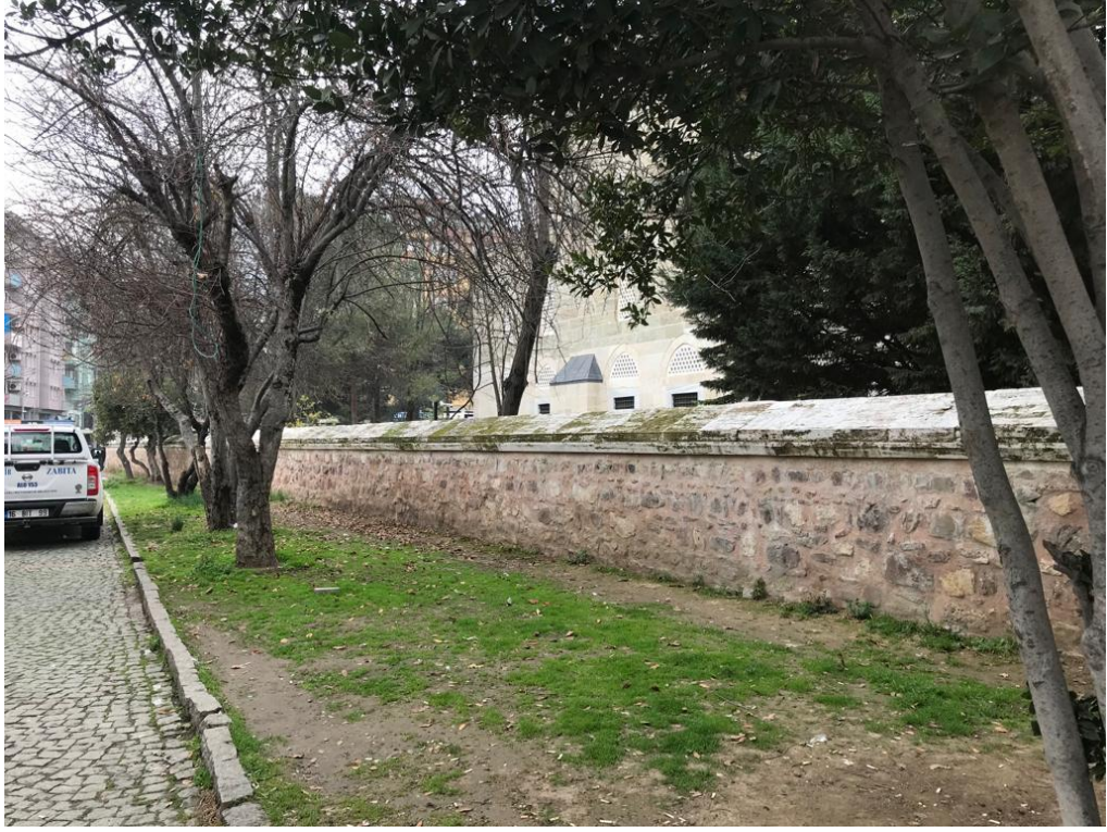
Fotoğraf 17. Güney cephe avlu duvarı (Eylül 2021)
