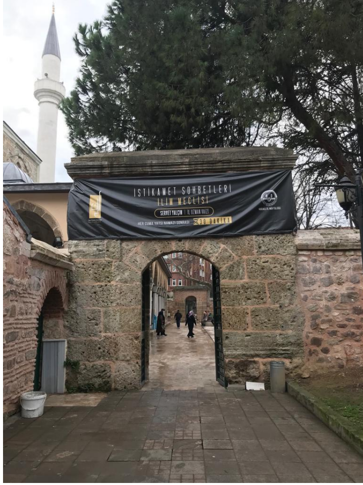
Fotoğraf 15. Doğu cephe ön avlu duvarı giriş kapısı (Eylül 2021)
