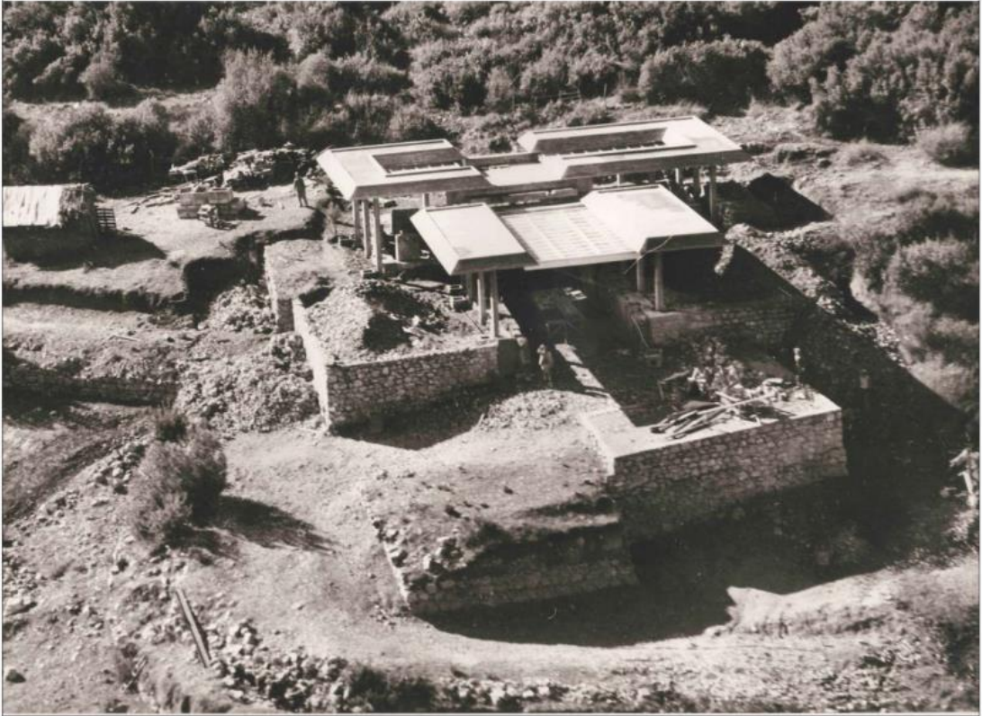
Şekil 4.20. Turgut Cansever'in saçakları (Kuzey Kapı) [56].
