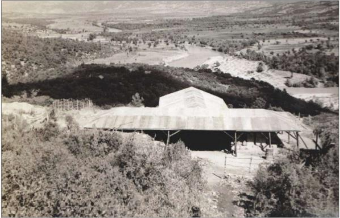
Şekil 4.16. Geçici dalgalı saç çatı [56].
