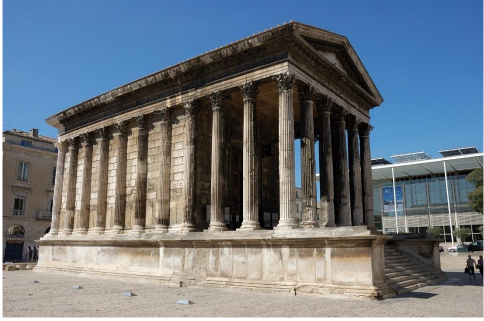
Şekil 2.2. Maison Carrée Tapınağı. Nîmes-Fransa [26].
