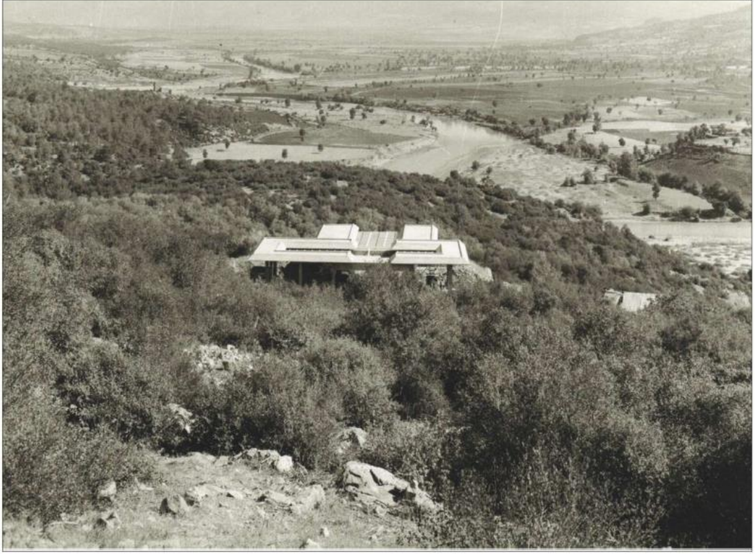
Şekil 4.21. Turgut Cansever'in saçakları (Kuzey Kapı) [56].
