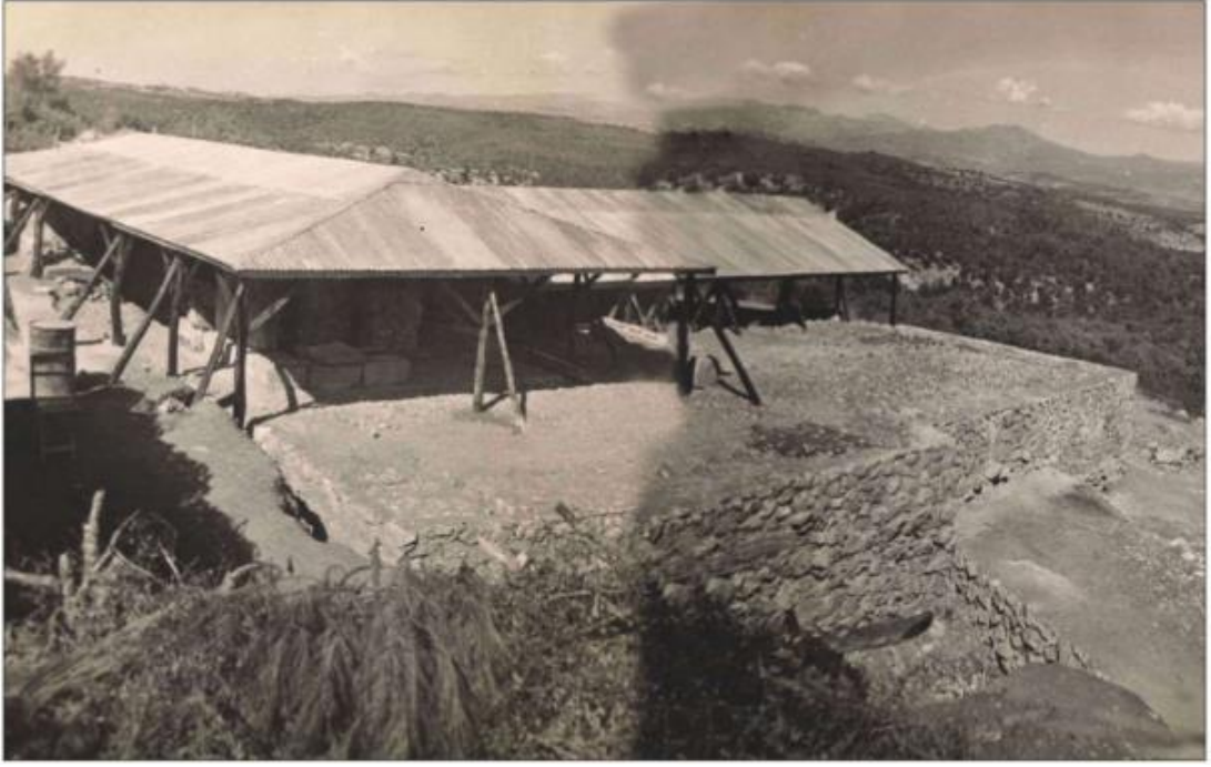
Şekil 4.15. Geçici dalgalı saç çatı [56].
