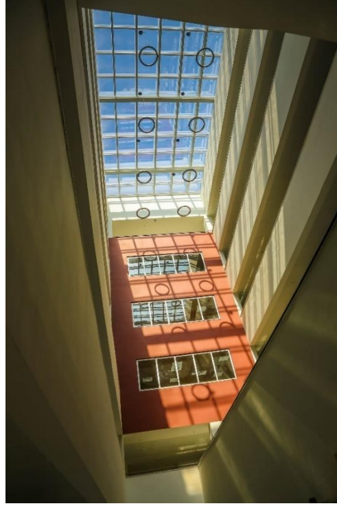
Şekil 5.1. ÖİM binası iç mekan görünümü.
