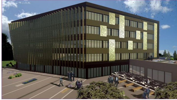
Şekil 3.19. Tapu ve Kadastro Müdürlüğü Binası.
