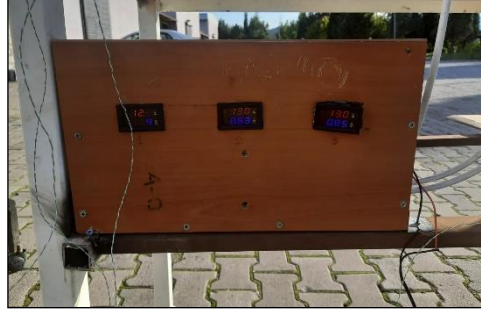
Şekil 4.10. PV Panel güç ölçüm cihazlarının montajı.
